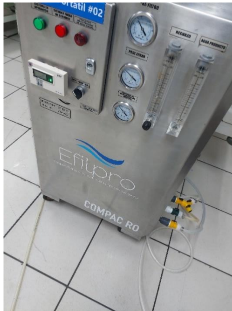
Ilustración 67- Instalación de equipo en Observación
