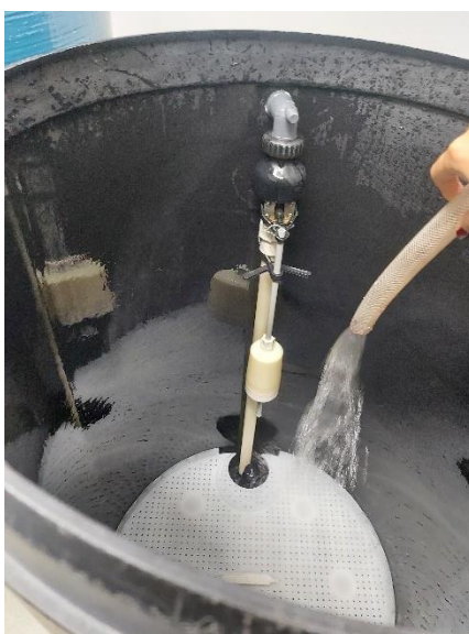
Ilustración 81- Desinfección de tanque de salmuera
