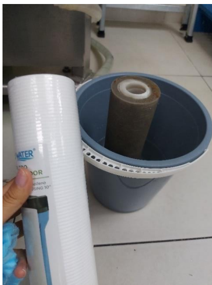
Ilustración 80- Reemplazo de filtro de osmosis portátil
