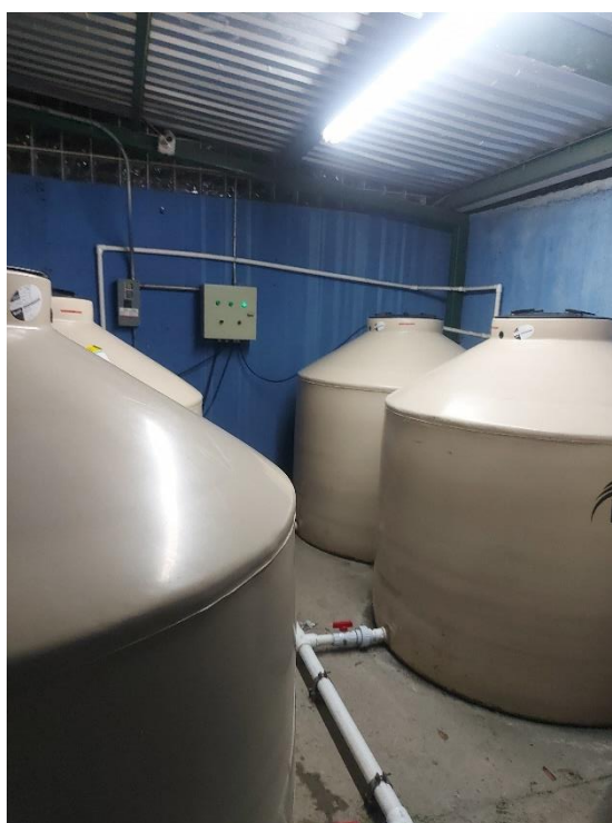
Ilustración 58-Inspección de área de almacenamiento de agua cruda
