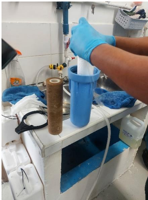
Ilustración 34- Reemplazo de filtro de osmosis portátil
