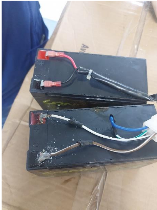
Ilustración 33- Cambio de batería de respaldo a máquina de emergencias
