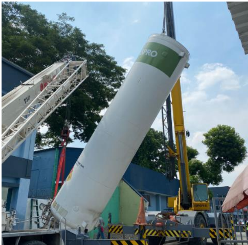
Ilustración 52 Tanque de oxígeno criogénico
