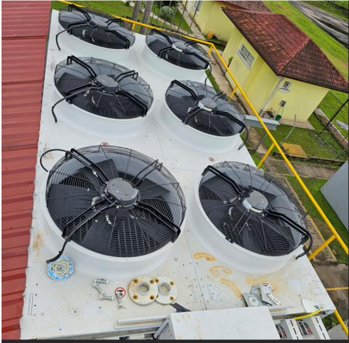
Figura 25. Radiador motor Guascor
