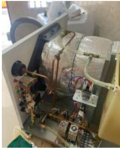
Ilustración 30. Mantenimiento STATIM 5000 G4.
