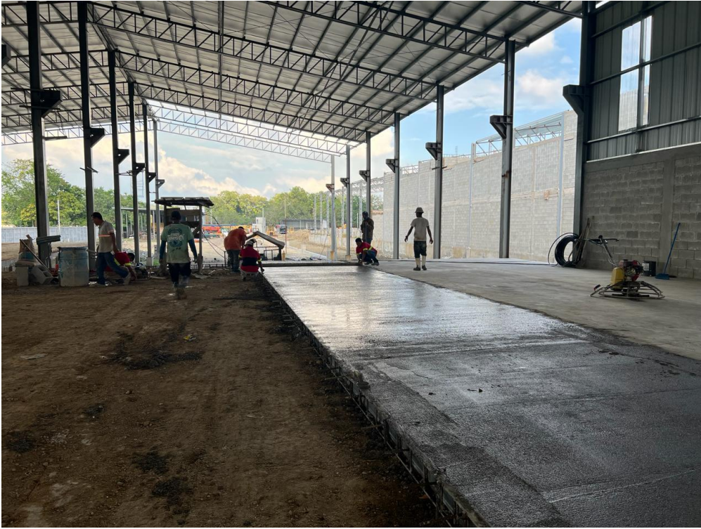
Anexo 1 – Fundición de firme de concreto premezclado
