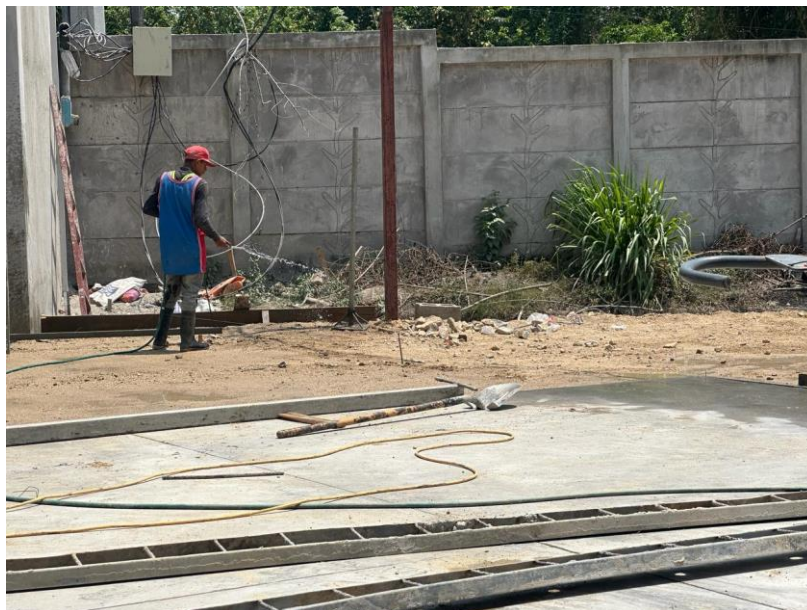
Ilustración 94 – Instalación de encofrado
