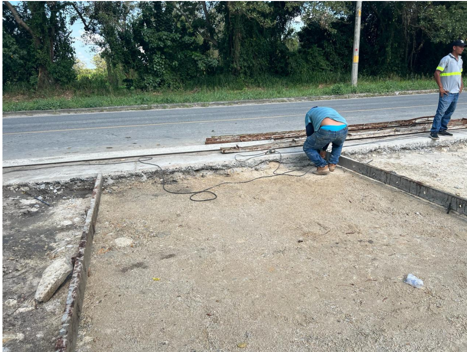
Ilustración 33 – Perforación del concreto existente
