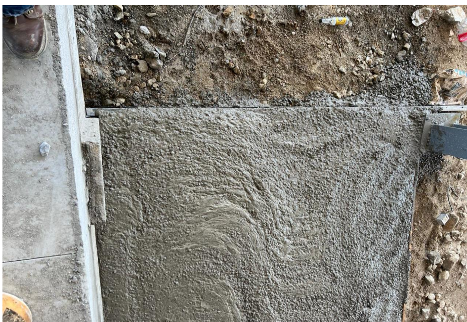
Ilustración 80 – Concreto fluido en rampa de acceso
