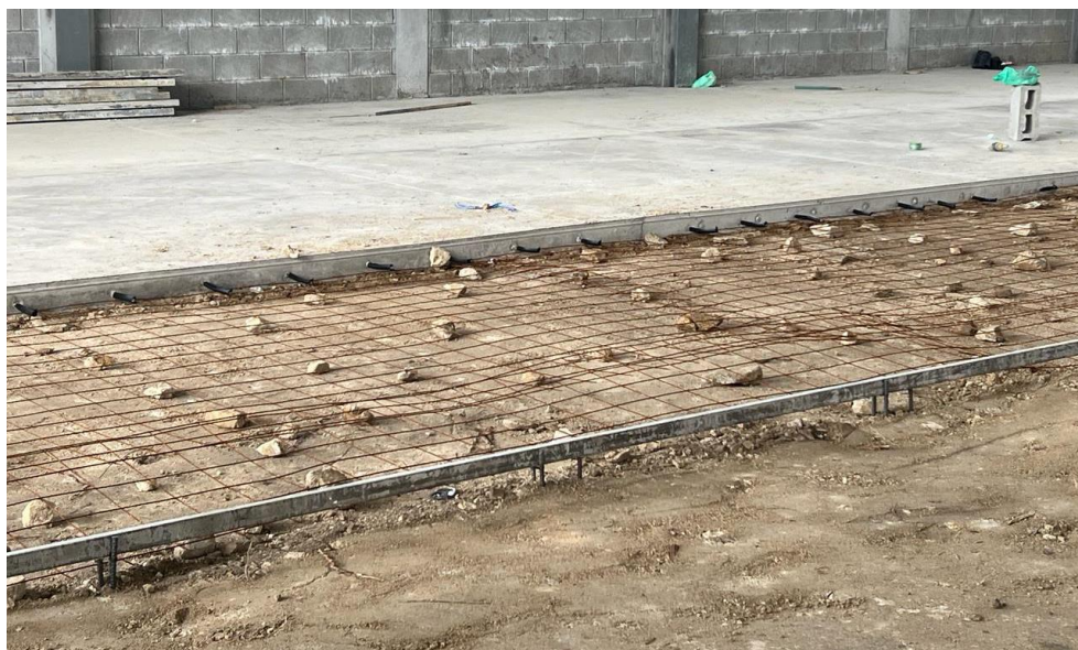
Ilustración 24 – Suspensión de malla
