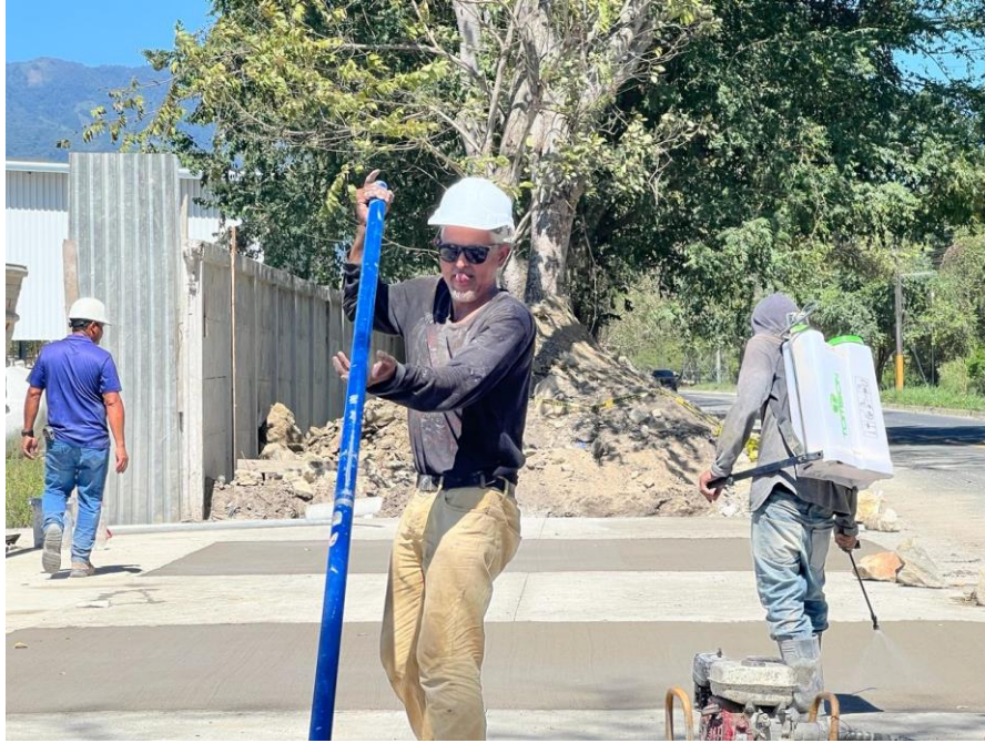
Ilustración 39 – Dianado en el concreto fresco
