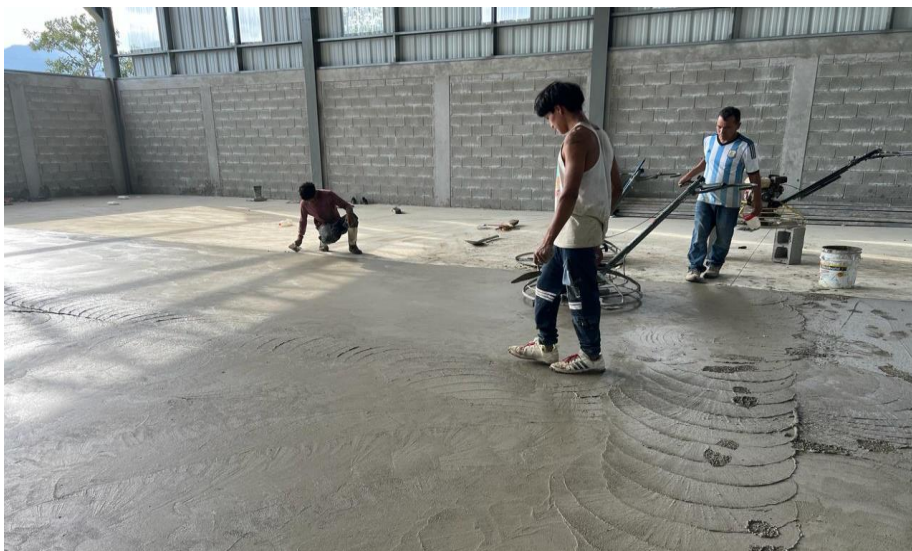
Ilustración 30 – Pulido de firme
