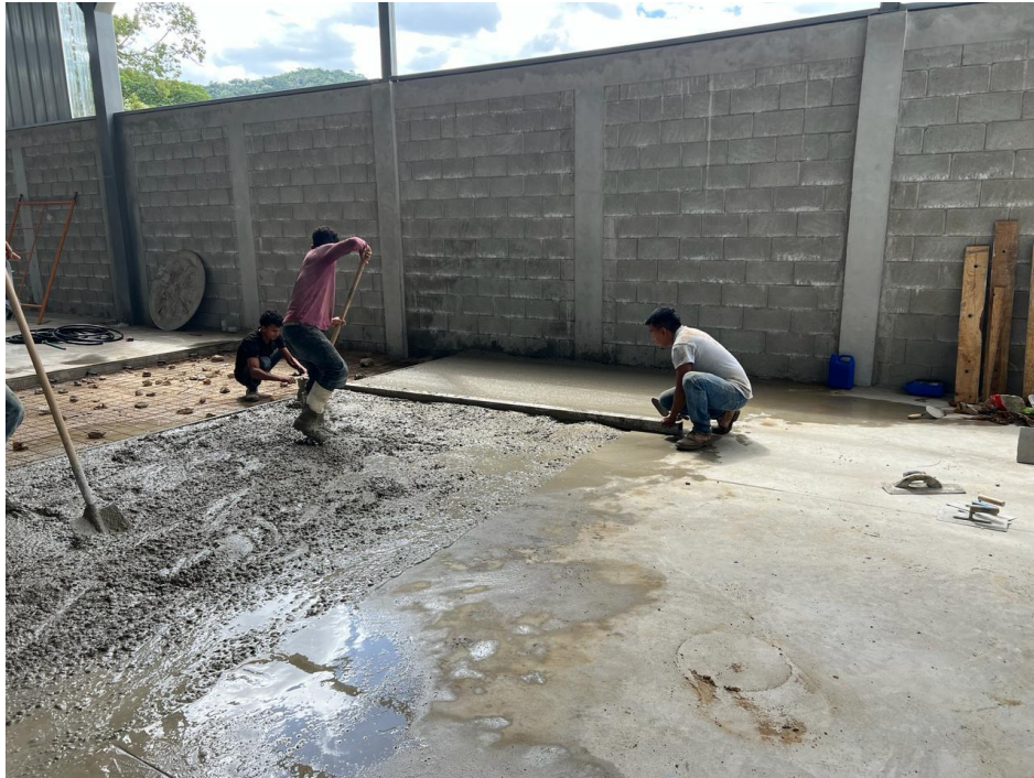
Ilustración 28 – Rastreado de concreto fresco
