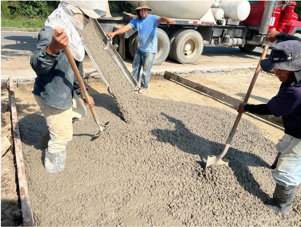
Ilustración 36 – Colocación de concreto
