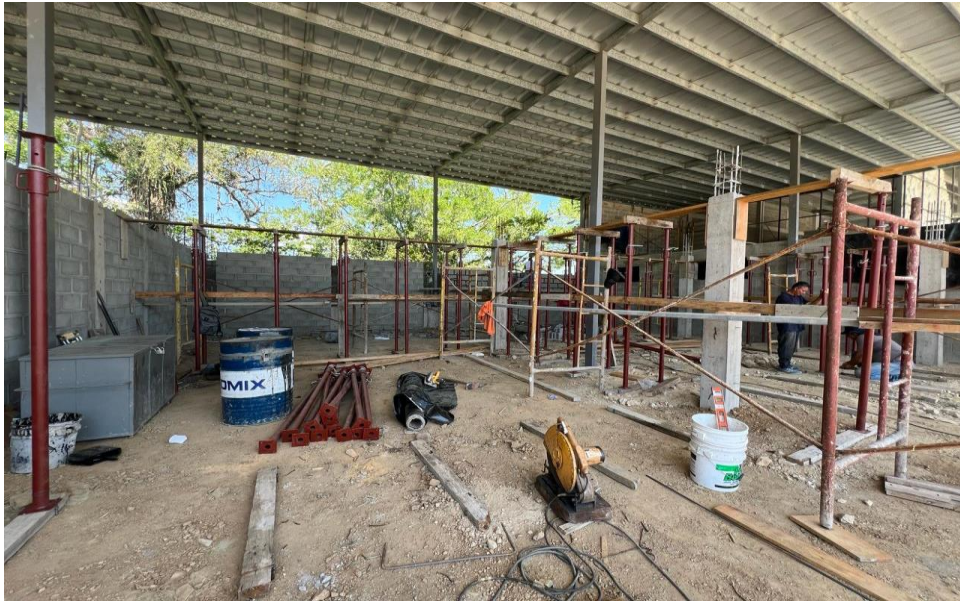
Ilustración 69 – Piloteado para fundición de vigas aéreas
