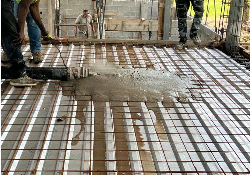
Ilustración 89 – Vertido de concreto en losa de entrapiso
