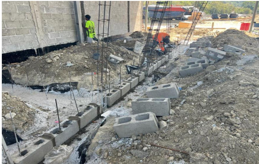
Ilustración 74 – Sobreelevación de bloques
