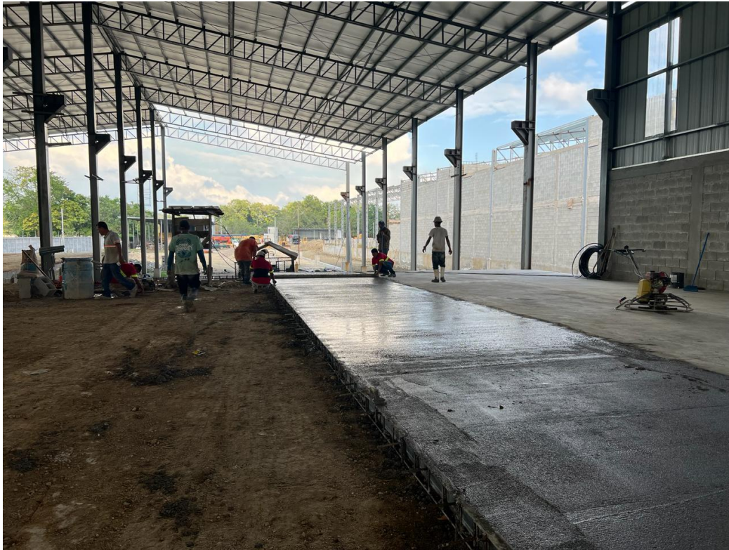
Ilustración 12 – Concreto fluido
