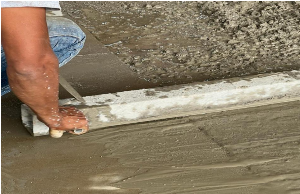
Ilustración 29 – Remoción de excesos en los bordes de concreto existente
