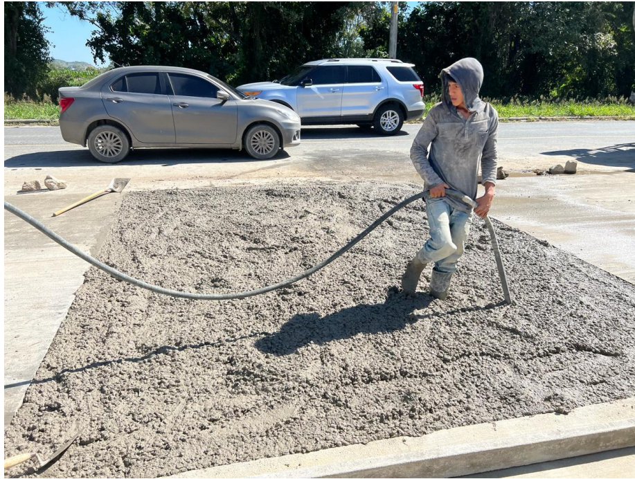
Ilustración 37 – Vibrado de concreto
