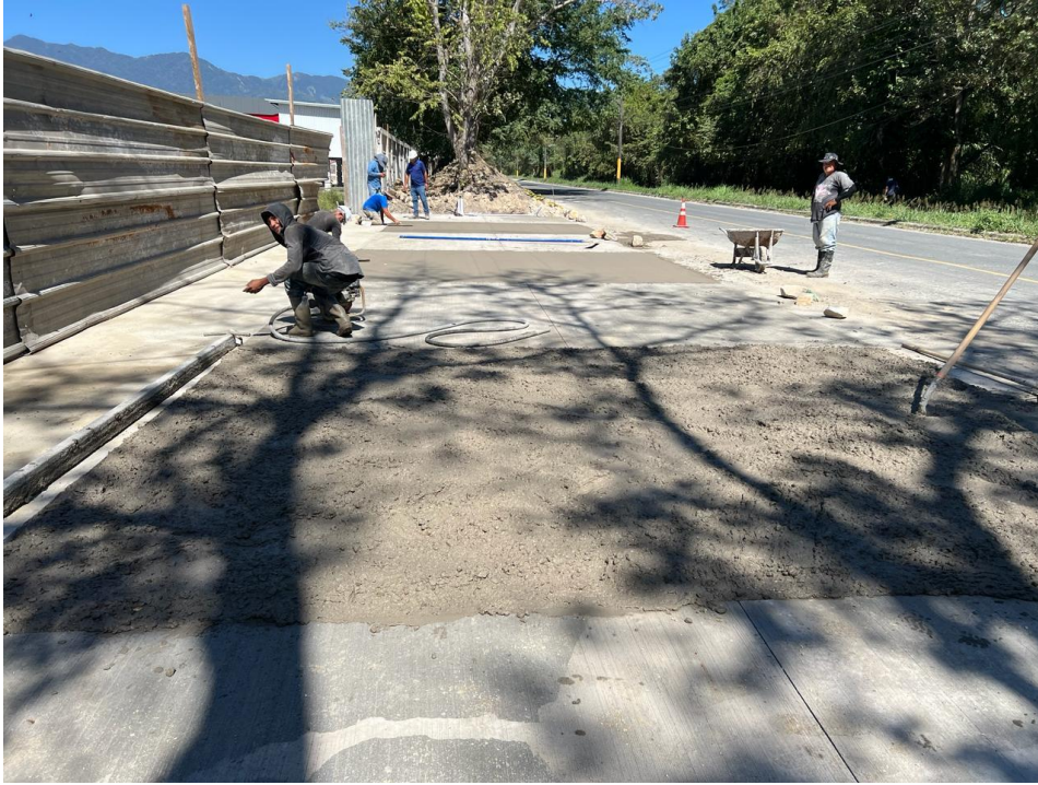
Ilustración 38 – Rastreado de concreto fresco
