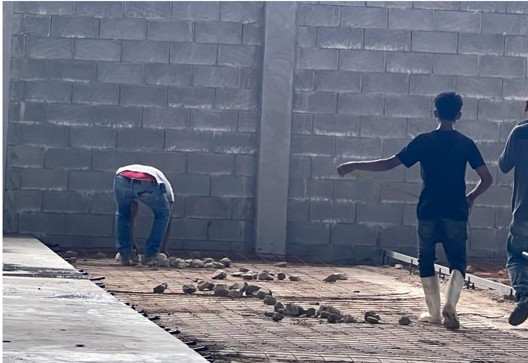
Ilustración 23 – Instalación de malla electrosoldada
