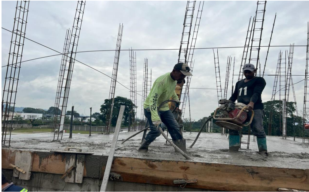
Ilustración 19 – proceso de vibrado
