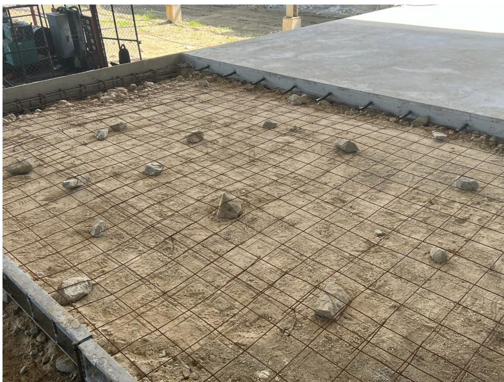
Ilustración 8 - Suspensión de malla metálica
