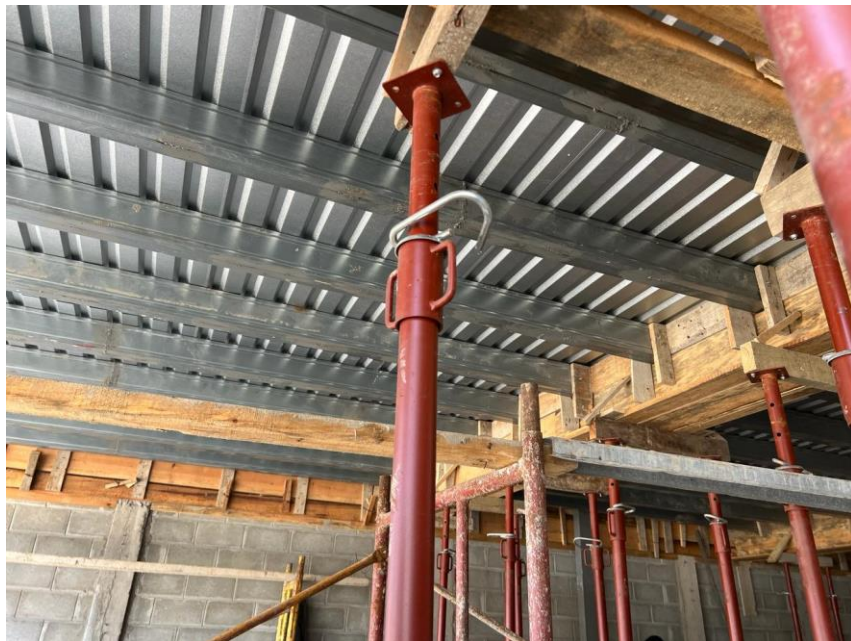
Ilustración 84 – Detalle de encofrados en vigas aéreas
