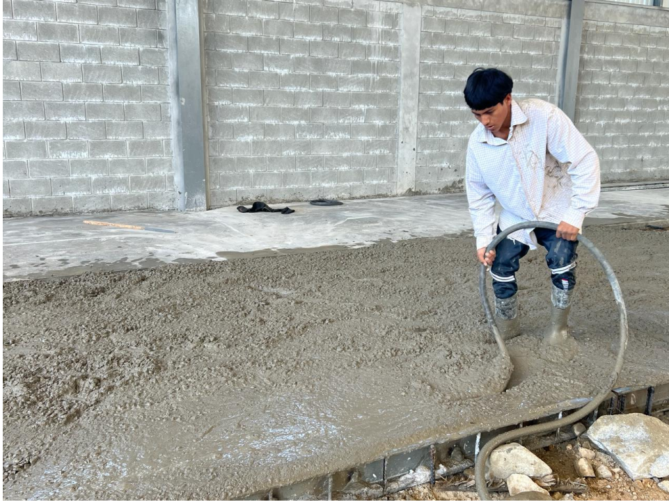
Ilustración 27 – Vibrado de concreto
