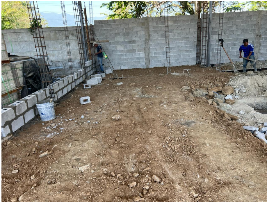
Ilustración 57 – Avance de hiladas de bloque
