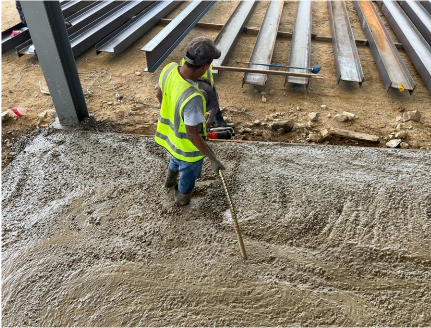
Ilustración 79 – Vertido de concreto en rampa de acceso
