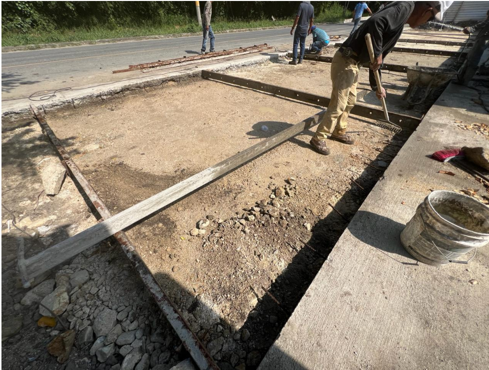
Ilustración 32 – Nivelación y conformación
