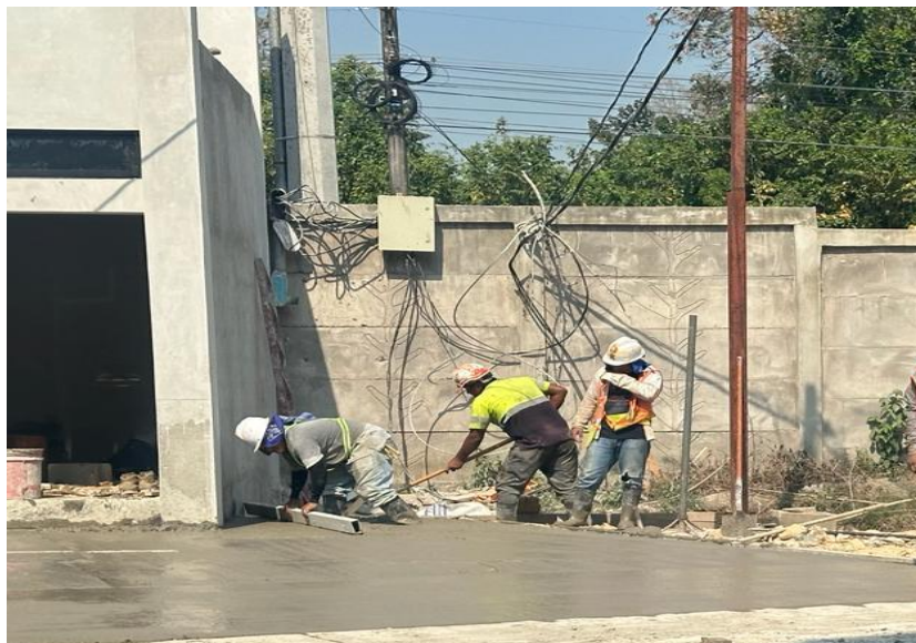
Ilustración 97 – Rastreado de concreto fresco
