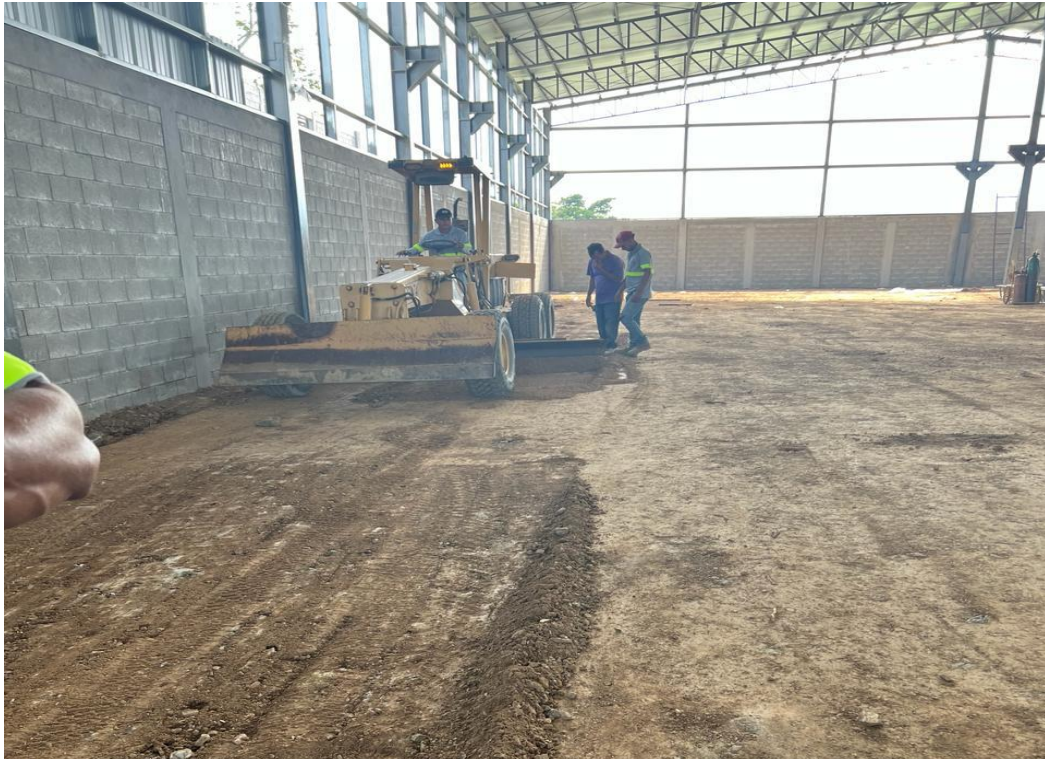
Ilustración 7 - Nivelado y preparado de terreno
