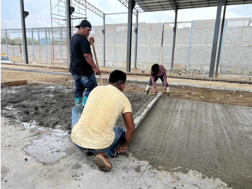
Ilustración 52 – Rastreado de concreto fresco
