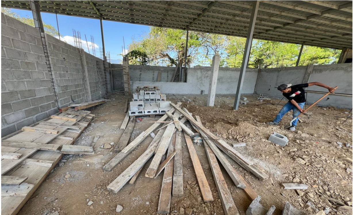
Ilustración 71 – Relleno del área de comedor
