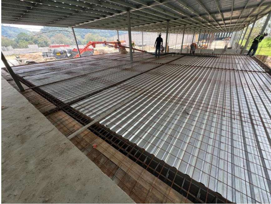
Ilustración 86 – Área de fundición de entepiso
