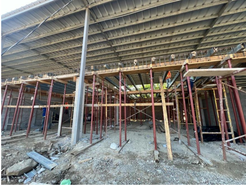
Ilustración 83 – Instalación de encofrado
