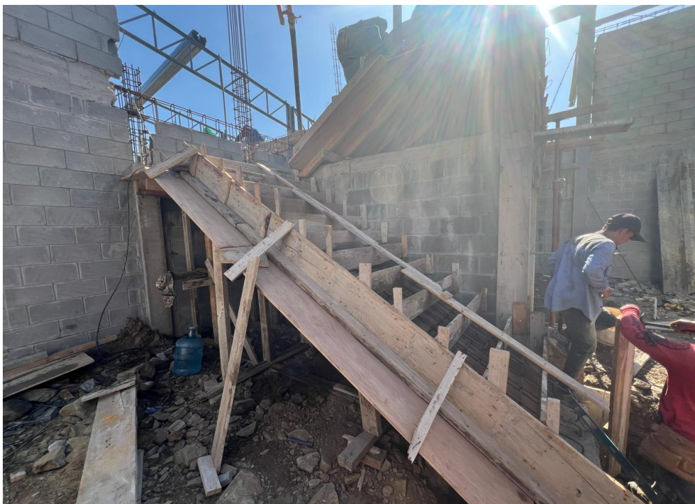
Anexo 4 – Encofrado de gradas para entrespiso
