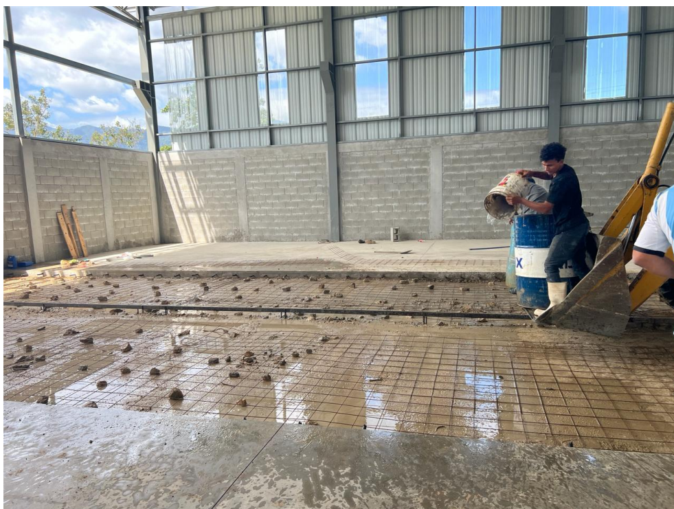
Ilustración 25 – Mojado de área de fundición
