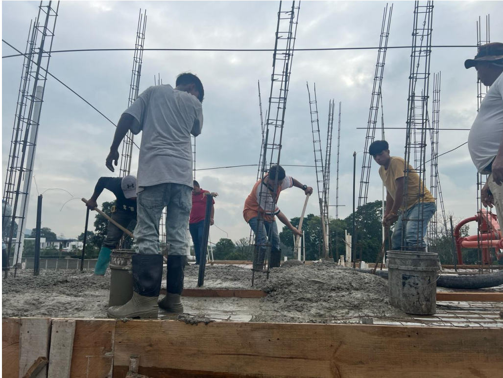
Ilustración 14 – Fundición de losa de entrecimpo
