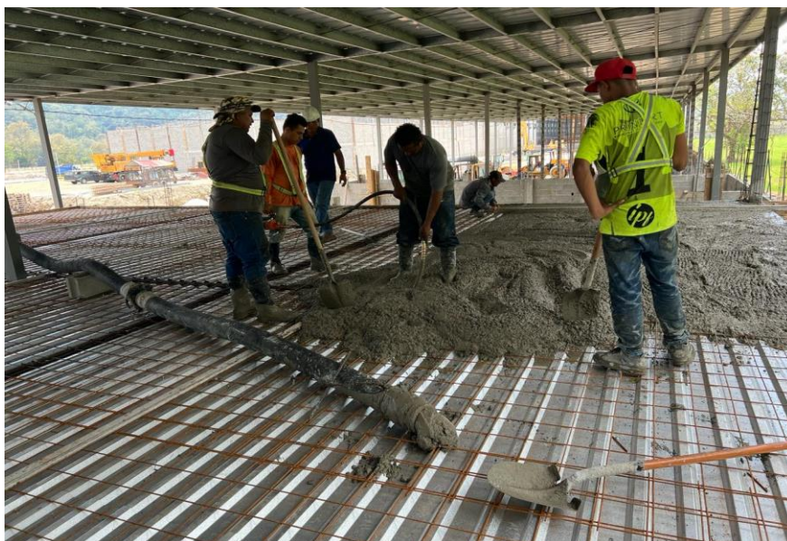
Ilustración 91 – Vibrado de concreto en losa y en vigas aéreas
