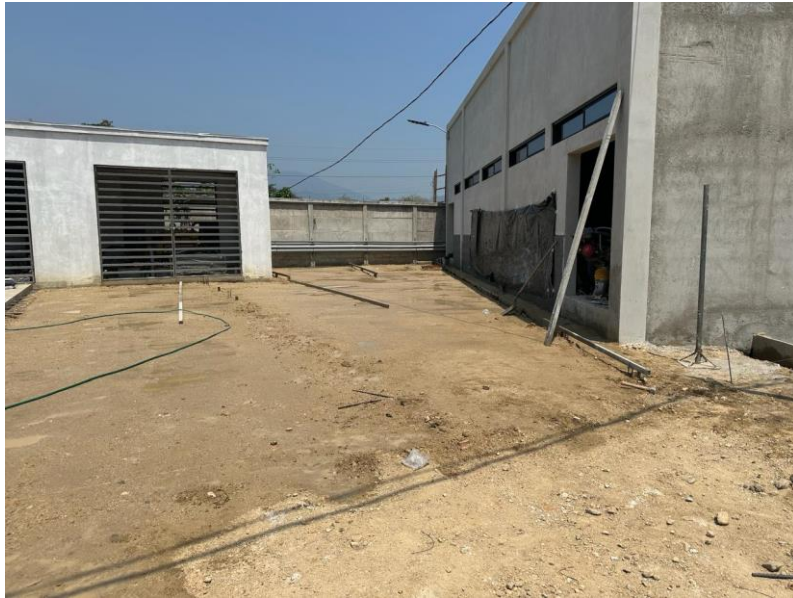
Ilustración 93 – Nivelación y conformación
