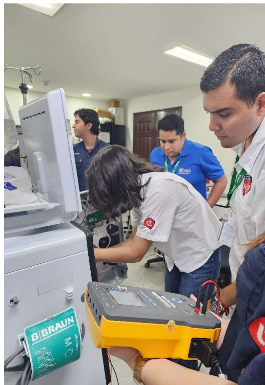
Ilustración 68.- Pruebas de seguridad eléctrica
