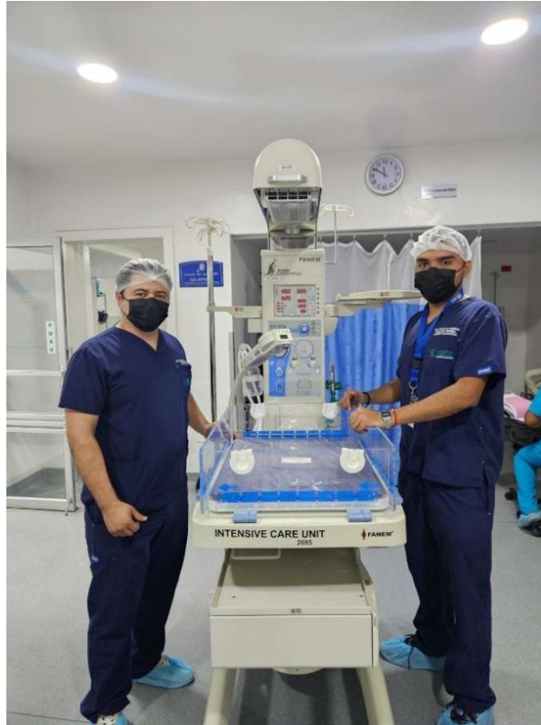
Ilustración 39.-Instalación de Cuna Neonatal (Hospital Bendaña)
