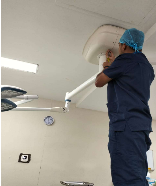
Ilustración 49.- Desinstalación de carcasa principal
