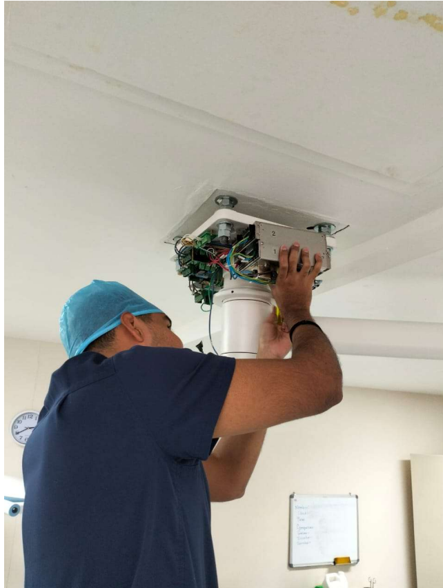
Anexo 28.- Desinstalación de componente de falla
