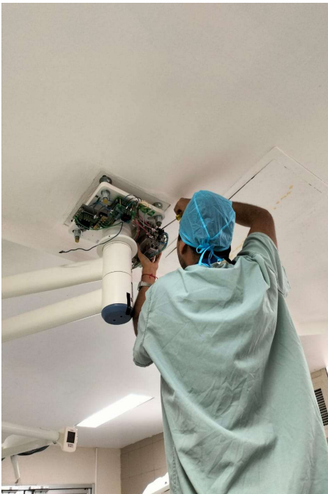
Ilustración 73.- Mantenimiento Correctivo Lampara Quirúrgica de Techo
