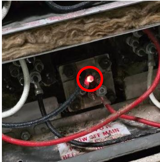
Ilustración 61: Resistencia con Sobrecalentamiento
