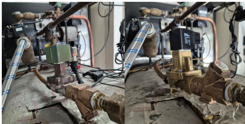
Ilustración 30: Reemplazo de Válvula Solenoide
