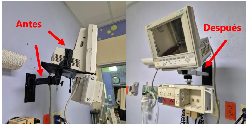
Ilustración 40: Instalación de Monitor de Signos Vitales
