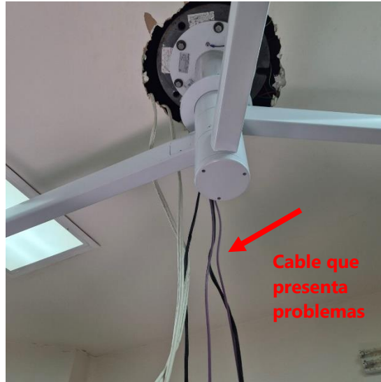
Ilustración 45: Empotramiento de Lámpara Cialítica
