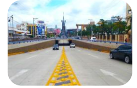
Puente paso a desnivel y túnel, intersección Blvd Centroamérica
