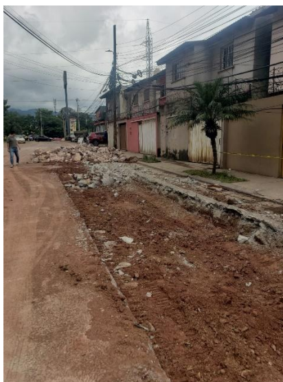
Ilustración 35. Demolición de pavimento para continuar excavaciones
