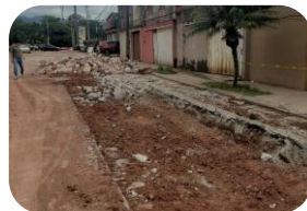
Rehabilitación Vial Distrito VII
