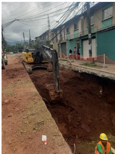
Ilustración 34. Excavación en calle para reemplazar tubería de agua residuales
