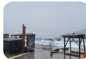
Remodelación y Ampliación de Obras Hospitalarias en el Hospital Escuela
