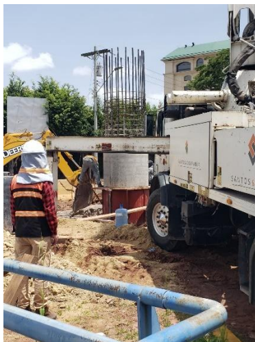
Ilustración 22. Bombeo concreto 5000 psi viga capitel en una de las pilas
