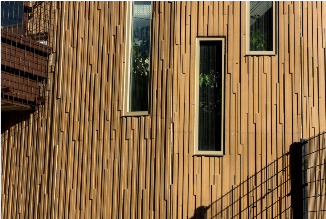
Figura 08. Detalle arquitectónico en fachada
