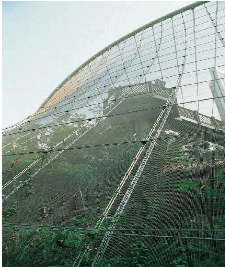
Figura 06. Vista de acercamiento de estructura
