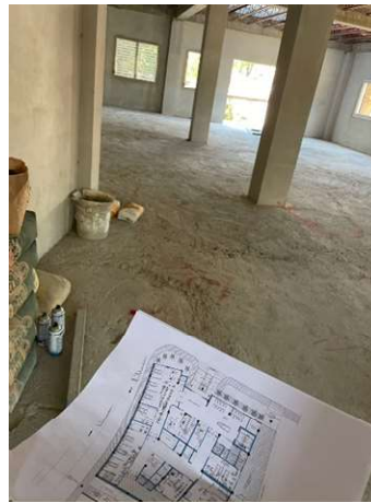
Ilustración 22 Visita de Obra Gris
