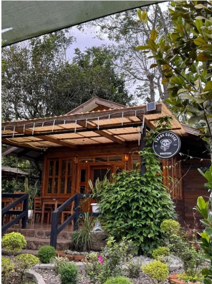
Fachada y acceso principal de Frank Coffee.
