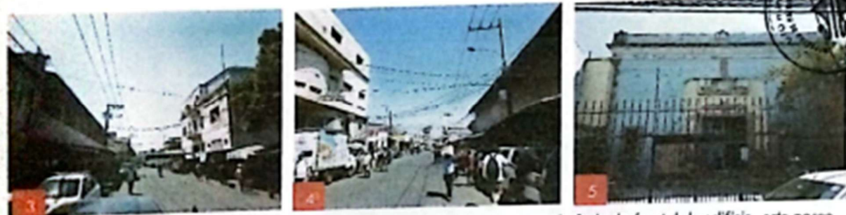
Img. 3-5. Vista de contexto, 6ta Avenida, Comayagüela, en la imagen 5 se aprecia fachada frontal de edificio, este posee arremetimiento de fachada y cerramientos metálicos
