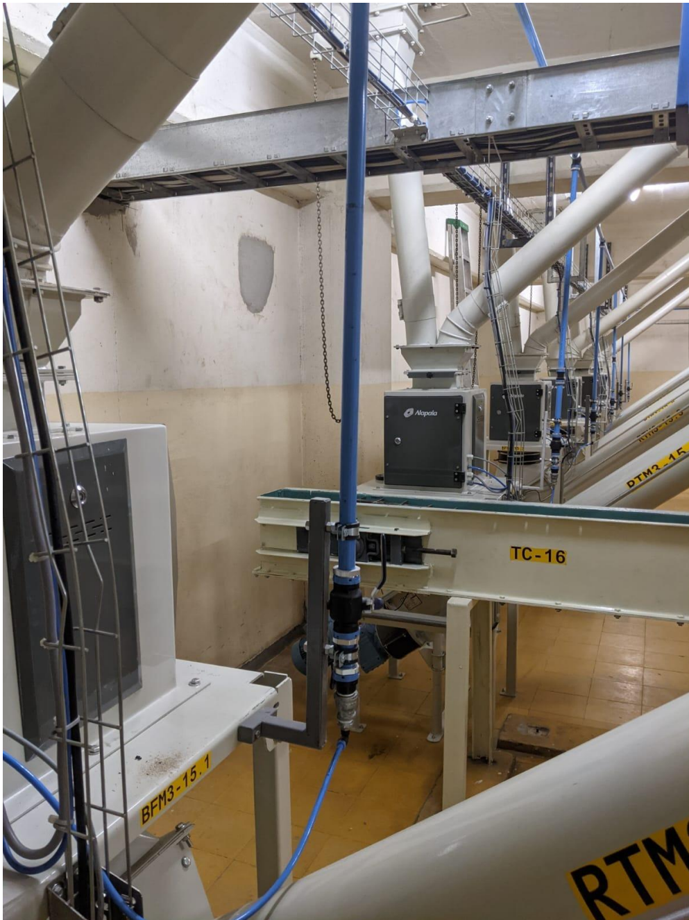
Ilustración 15 Instalación de todos los ponderales bajo cajones de silo 15
