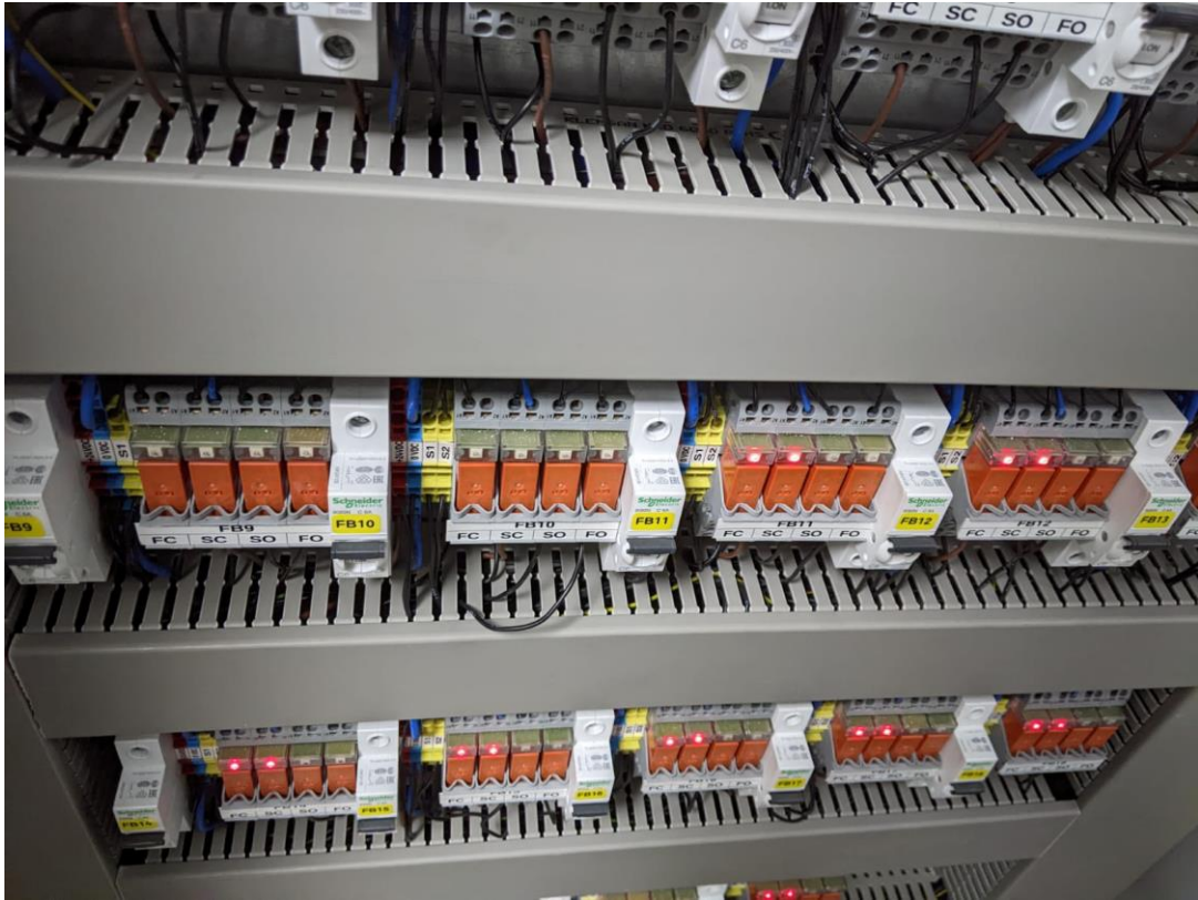
Ilustración 13 Reles individuales para FB en panel de control
