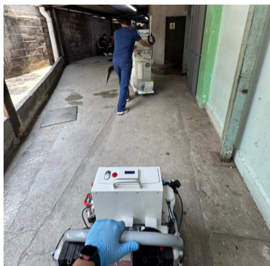
Ilustración 17: Instalación de equipos en UCIA
