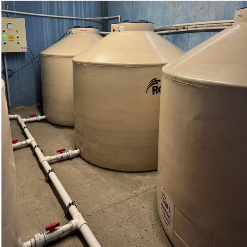
Ilustración 48: Limpieza tanques de agua cruda y sus bombas
