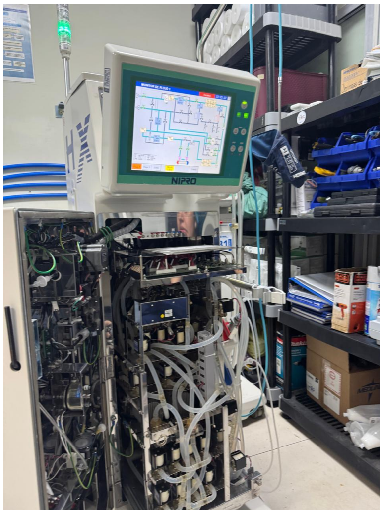
Ilustración 46: Mantenimiento correctivo a máquina de HD
