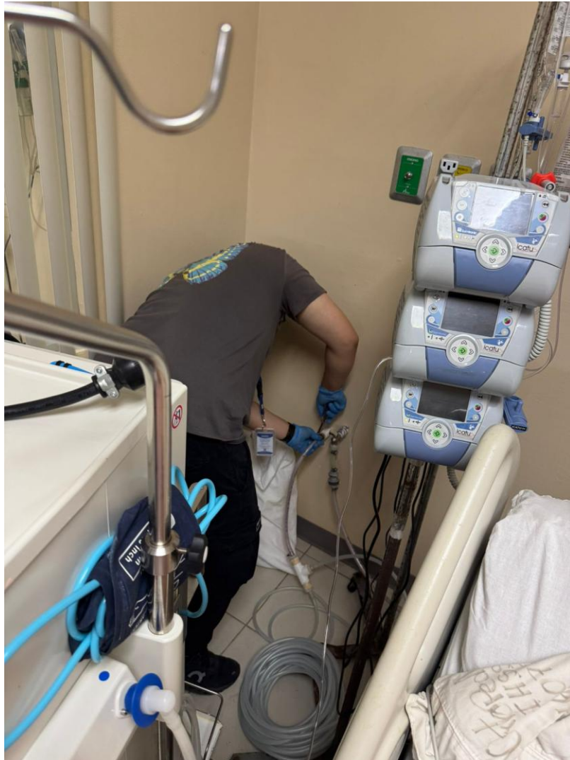
Ilustración 43: Instalación de máquina de HD en UCIA
