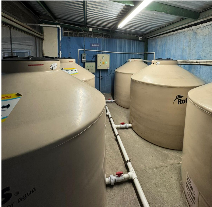
Ilustración 30: Limpieza de tanques de agua cruda
