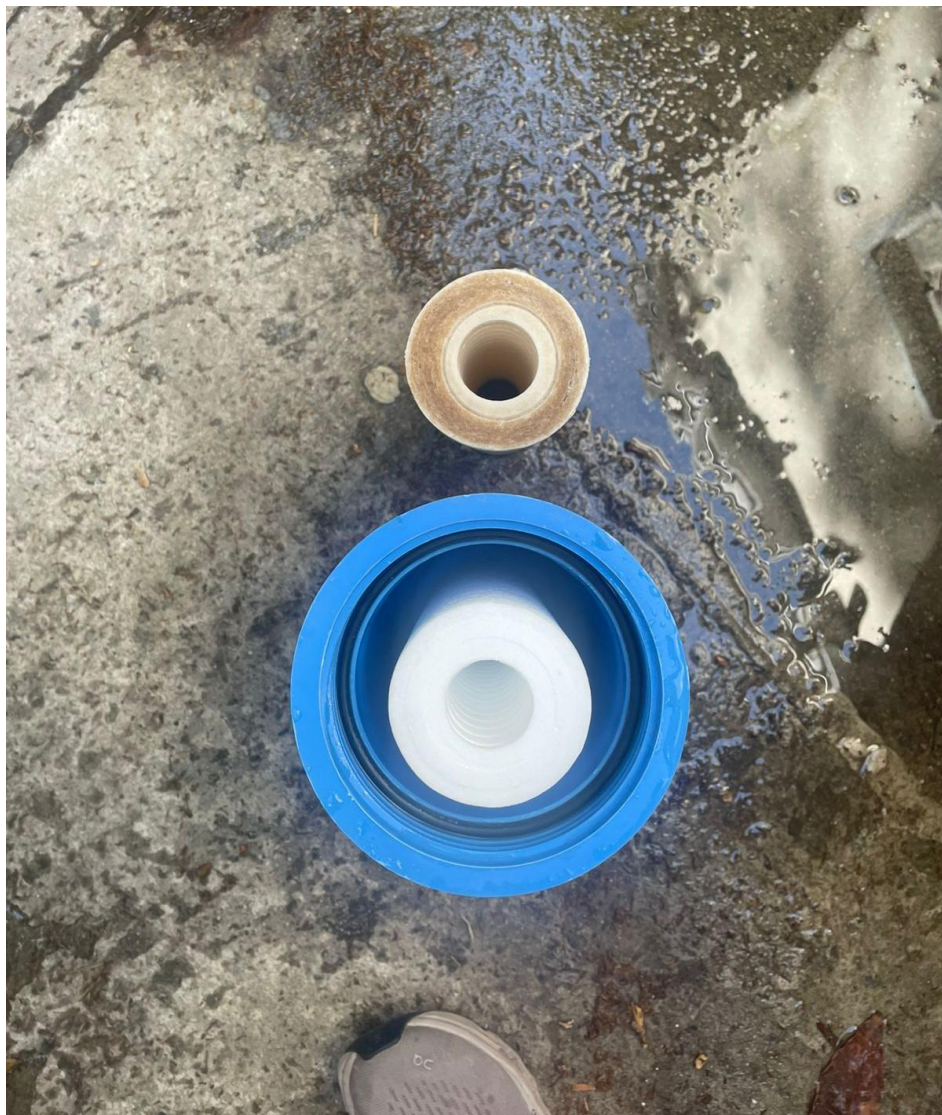
Ilustración 52: Cambio de filtro a osmosis inversa portátil
