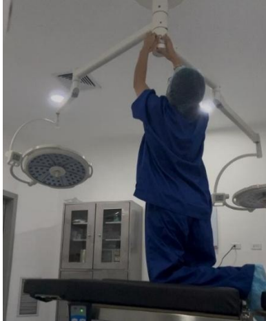
Ilustración 20. Ajuste de lámpara cirúrgica
