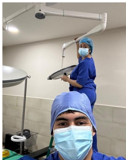
Ilustración 15- Mantenimiento correctivo y preventivo a Lámpara cielítica
