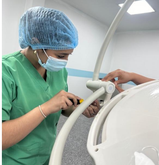
Ilustración 7- Instalación de controlador de lámpara Cieltica
