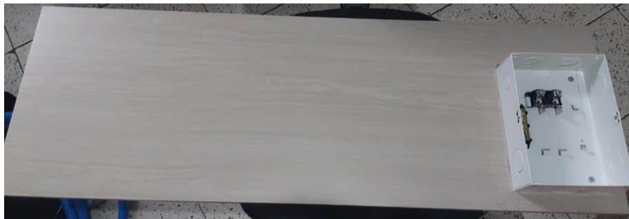
Figura 8.5 Montaje de panel de Breaker.
