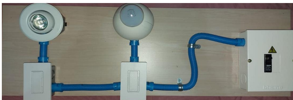
Figura 8.9 Conexión final de equipo.
