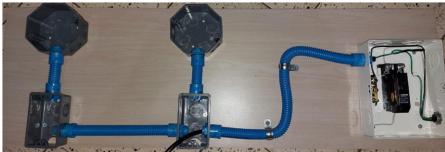
Figura 8.8 Instalación de tubería.
