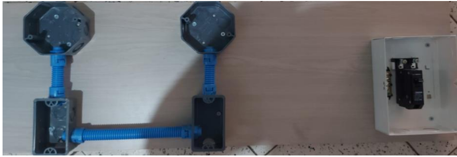
Figura 8.7 Montaje de cajas de registro.
