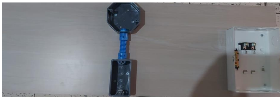
Figura 8.6 Montaje de panel de Breaker.
