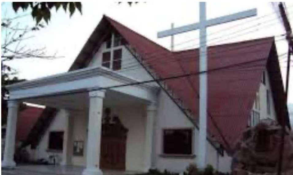
Figura 52. Fachada exterior Iglesia Santa Cruz de Tara
