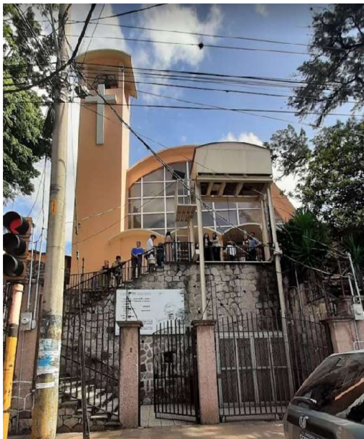
Figura 50. Fachada Iglesia San Martín de Porres
