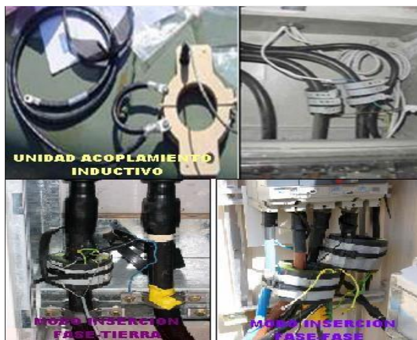
Figura 4.21 Unidad de acoplamiento inductivo BT y modos de inserción Fuente:
