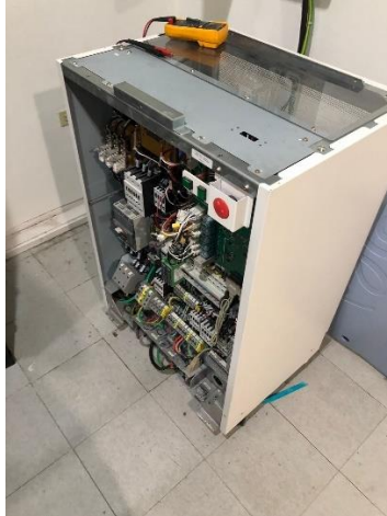
Ilustración 9. Desarme de Carcasas en PDU de TAC.
