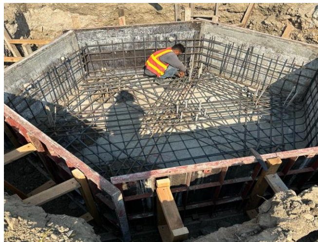
Ilustración 50- Encofrado y Armado de zapata aislada hexagonal.
