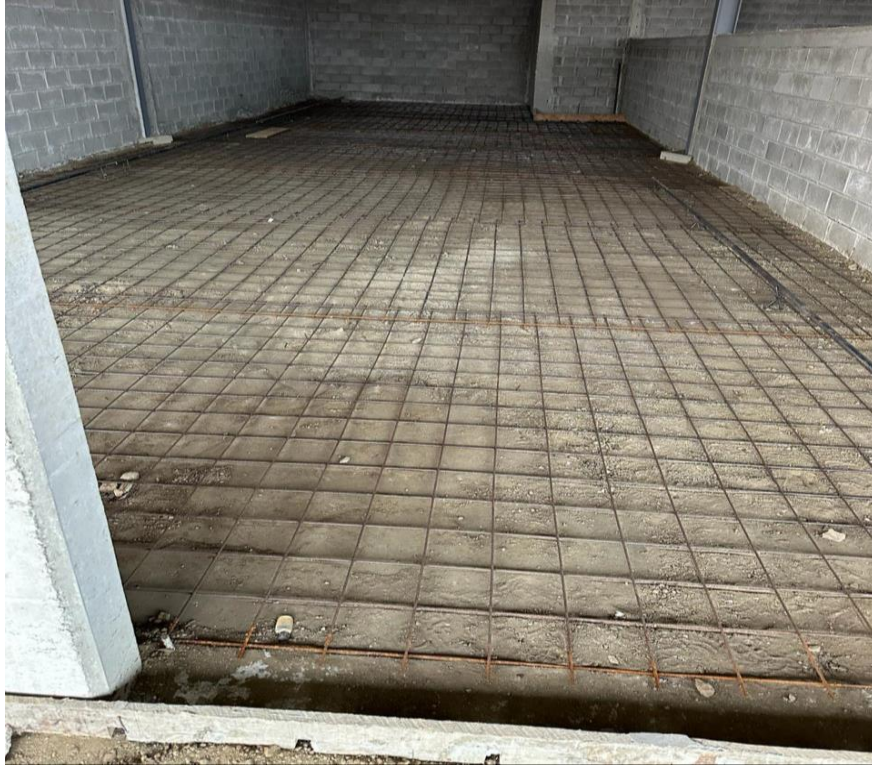
Ilustración 44- Colocación de malla electrosoldada.
