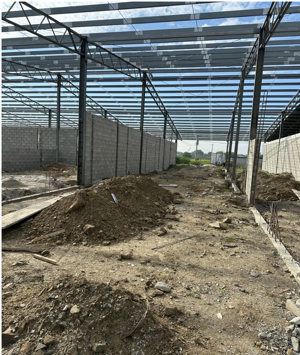
Ilustración 12- Revisión de estructura metálica para Forro de techo.
