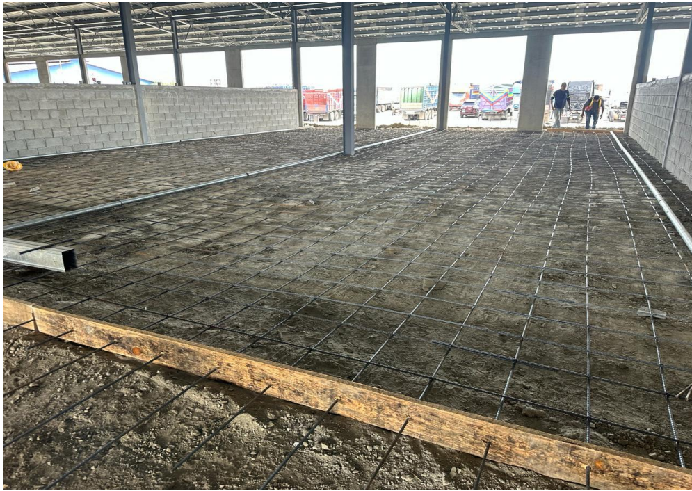
Ilustración 21- Preparación de locales para vertido de concreto
