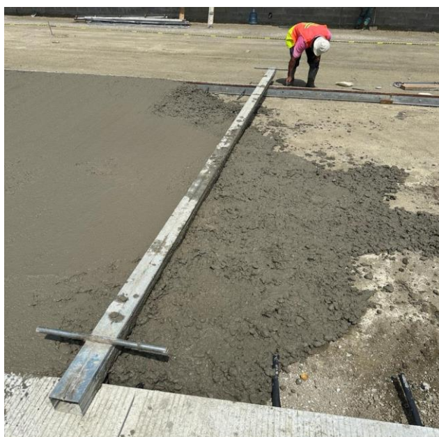
Ilustración 42- Colocación de concreto en trocha
