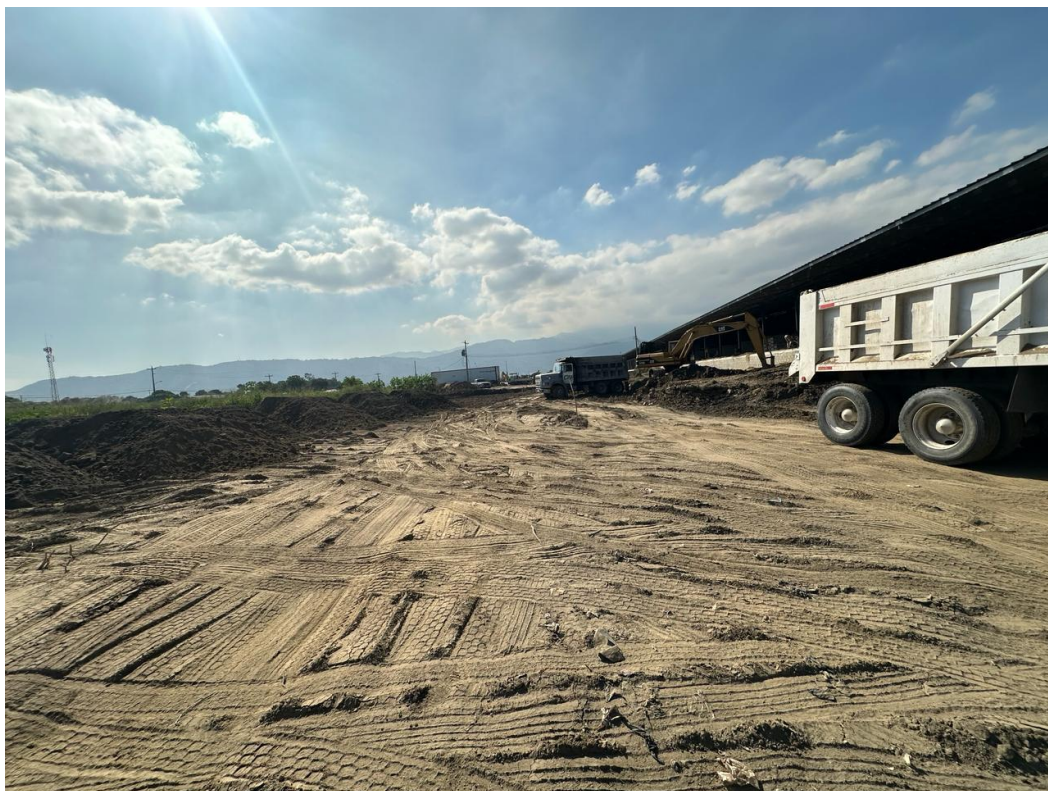
Anexos 4-Corte del terreno existente para Preparación de la Terracería
