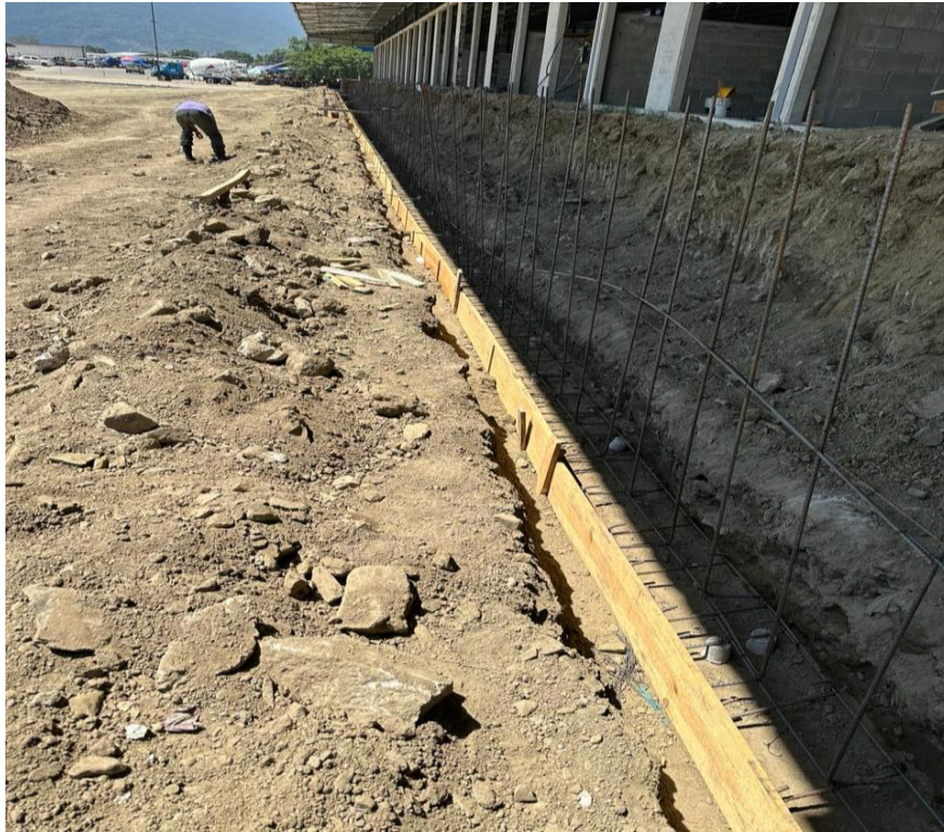
Ilustración 39- Construcción de tramo destruido del muro del andén
