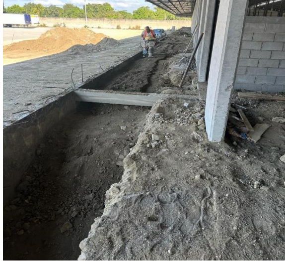
Ilustración 37- Excavación de relleno de muro lado trasero
