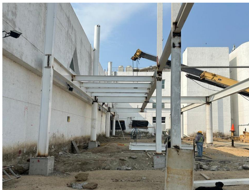
Ilustración 59- Colocación de estructura metálica Aeropuerto RVM.
