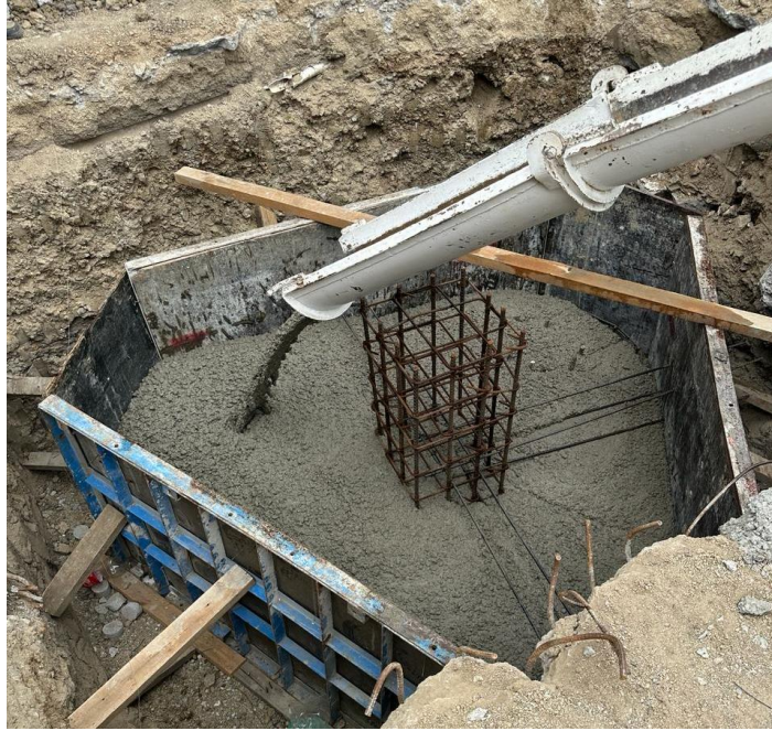
Ilustración 54- Vertido de Concreto en zapata aislada Triangular.
