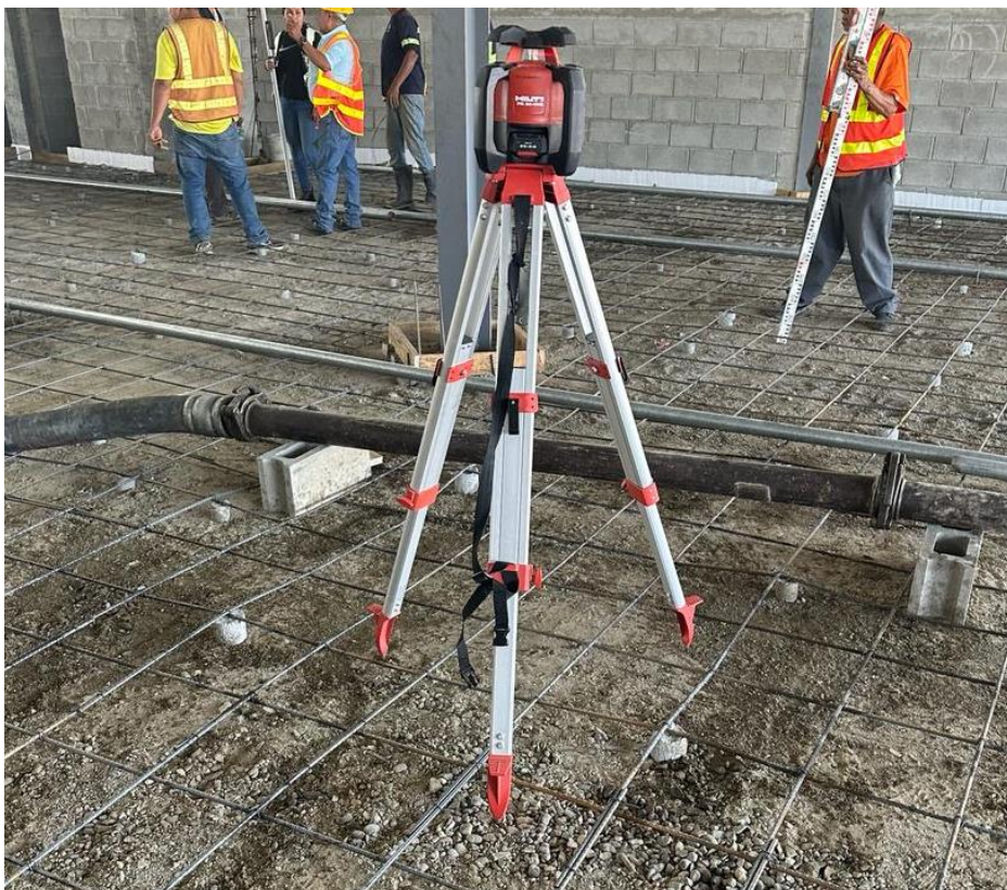
Ilustración 36- Nivelación de tubos a nivel de NPT.
