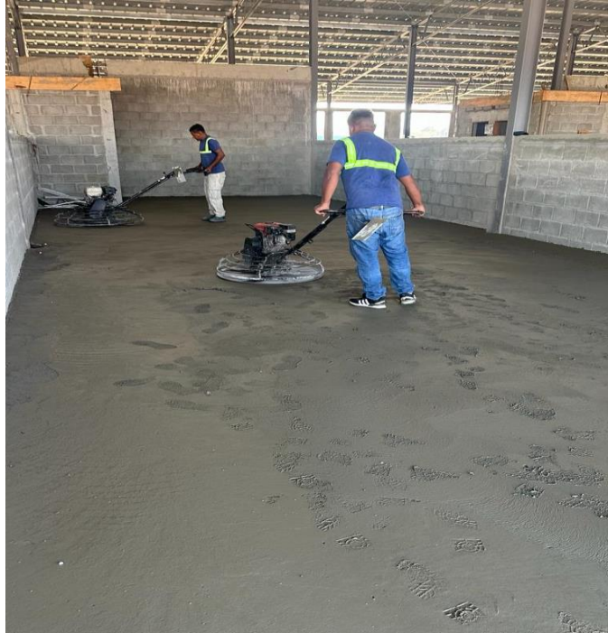
Ilustración 27- Allanado de firme de concreto.
