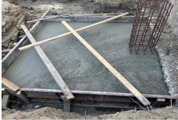
Ilustración 51- Construcción de zapata aislada cuadrada.
