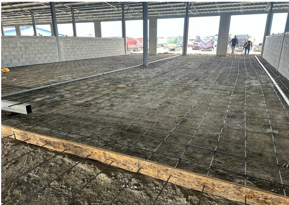
Ilustración 24- Locales listos para fundición de firme de concreto
