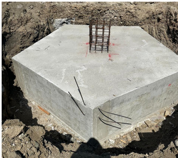
Ilustración 60- Zapata Pentagonal Aeropuerto RVM.
