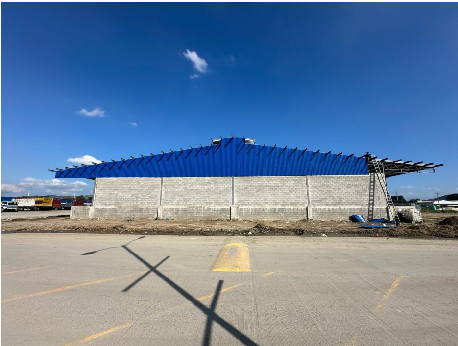
Anexos 2- Instalación de Forro de Culata Galpón 3
