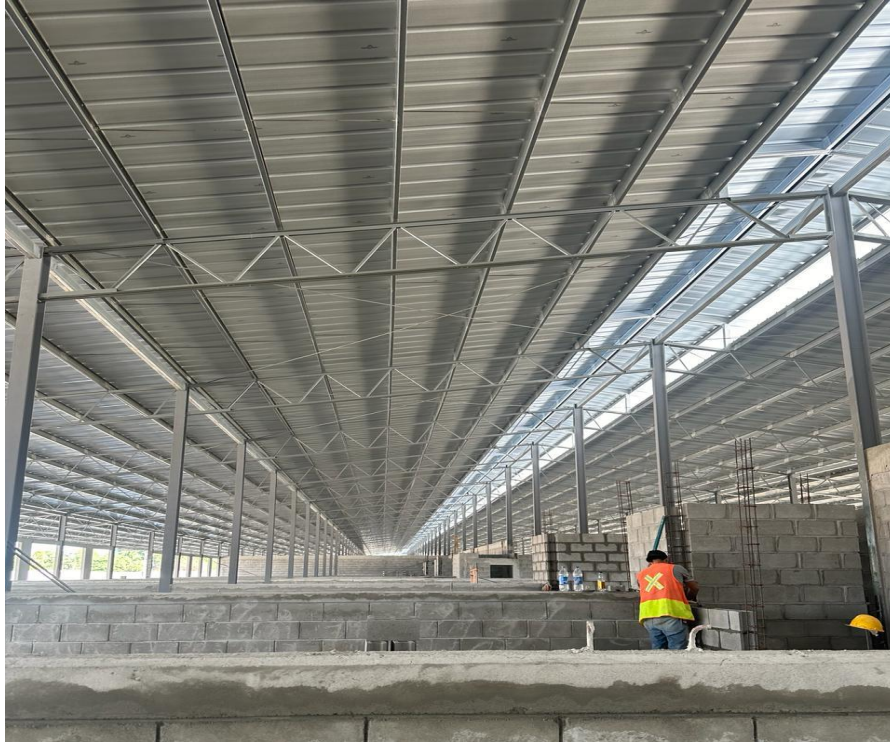
Ilustración 13- Colocación de Forro de Techo. Galpón 3
