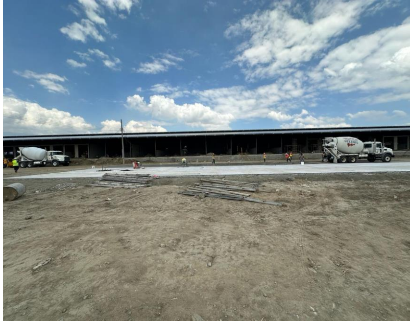
Ilustración 43- Vertido de Concreto en trocha de pavimento hidráulico.
