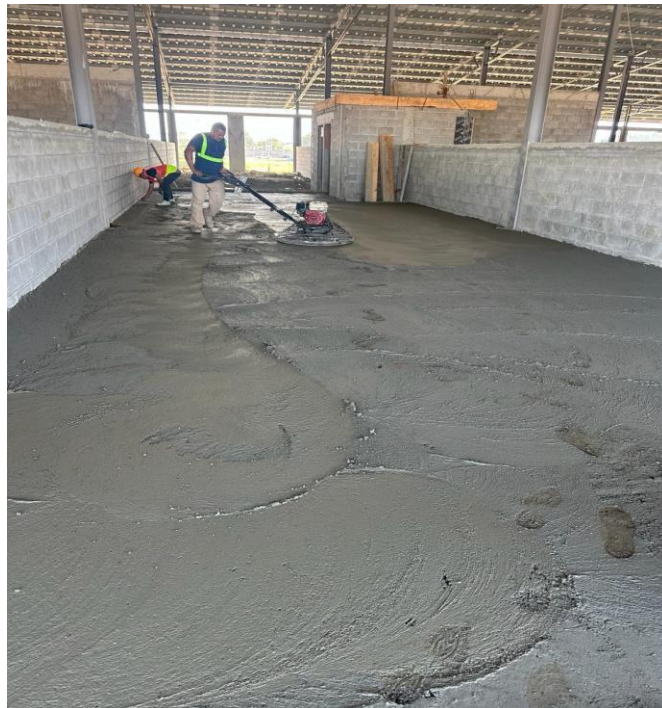
Ilustración 28- Proceso de allanamiento para acabado del firme de concreto.
