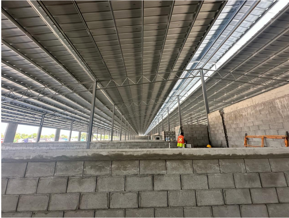
Anexos 1- Estructura de techo y mojinete terminada
