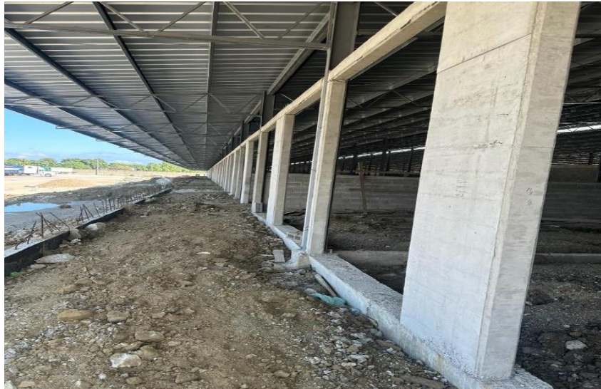
Ilustración 10- Levantamiento de la obra realizada en el proyecto.
