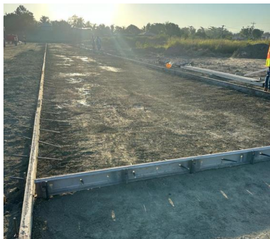
Ilustración 34- Encofrado de la trocha a pavimentar.
