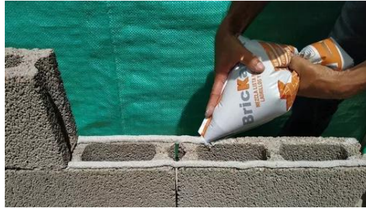
Ilustración 2 Aplicación de mortero polimérico Brickaffix en bloques de concreto
