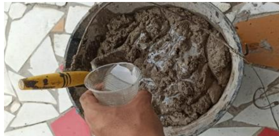
Ilustración 14 Adición de resina epóxica al mortero hidráulico
