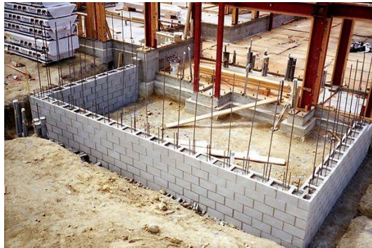
Ilustración 9 Construcción de Mampostería Reforzada con Mortero Tipo M
