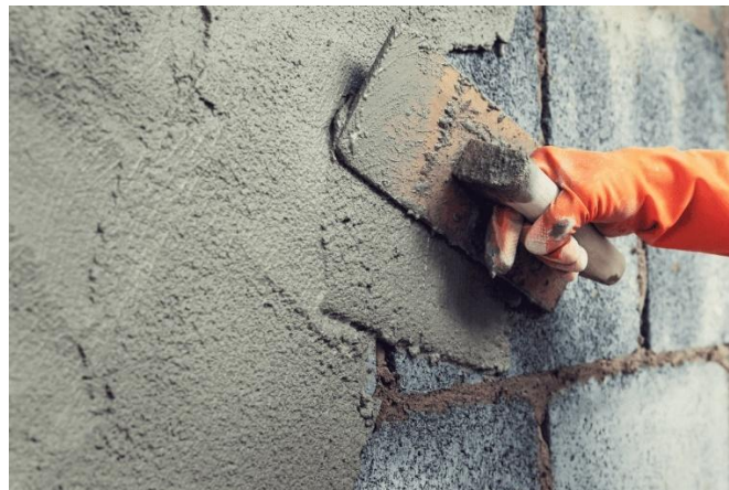
Ilustración 11 Revestimiento de Paredes Externas con Mortero Tipo N
