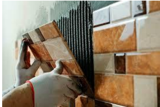
Ilustración 10 Instalación de Revestimiento Cerámico con Mortero Tipo S
