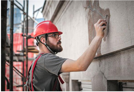
Ilustración 8 Reparación de fachada con mortero tipo H
