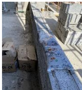
Ilustración 28 Instalación de celosía con mortero polimérico Brickaffix
