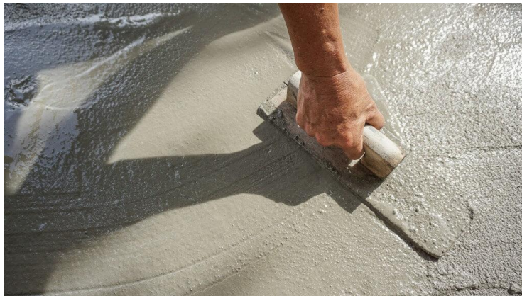
Ilustración 1 Nivelación de superficie de mortero hidráulico con llana
