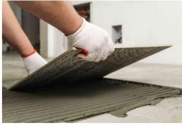
Ilustración 27 Aplicación de Mortero Hidráulico en la Colocación de Baldosas
