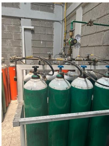
Anexos 3. Cambio de red de gases medicinales
