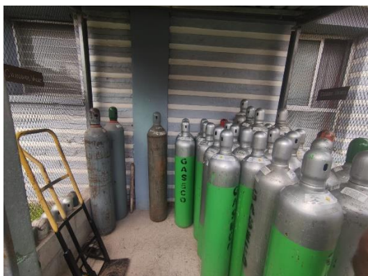
Ilustración 53 – Suministro de tanques
