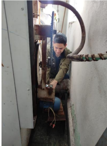
Ilustración 32 – Cambio de motor
