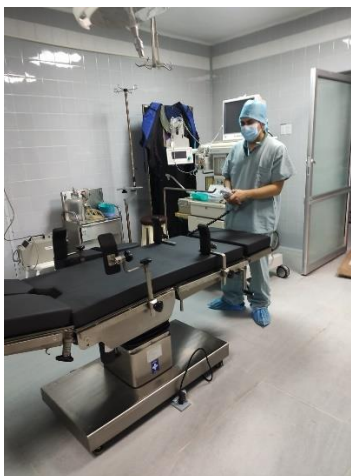
Ilustración 39 – Instalación y pruebas
