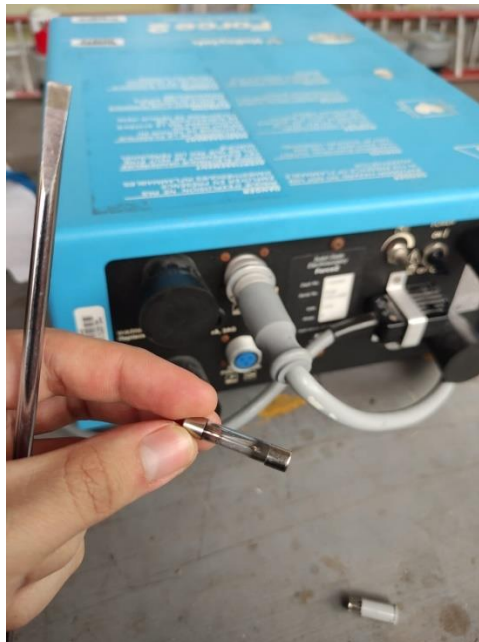
Ilustración 61 – Cambio de fusible
