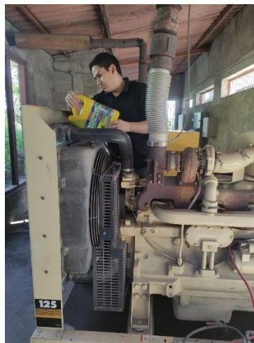
Ilustración 43 – Mantenimiento preventivo al generador
