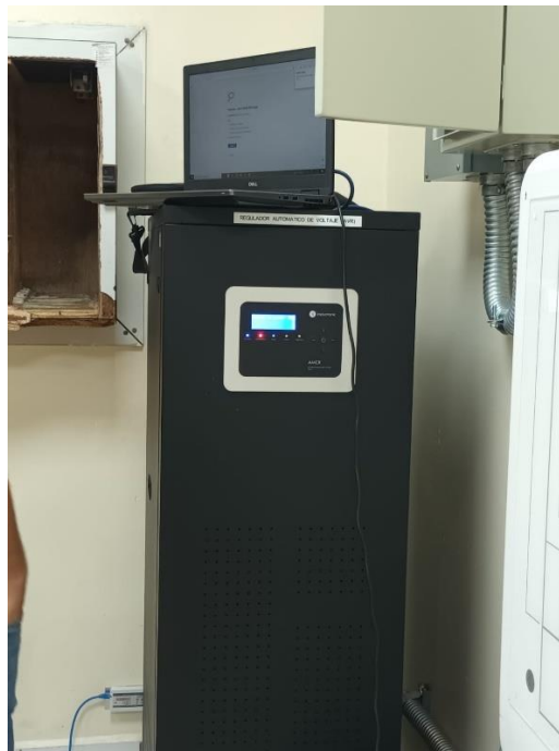
Ilustración 15. Regulador de Voltaje de RX.
