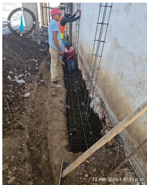
Ilustración 43 Armado de zapata de Muro perimetral
