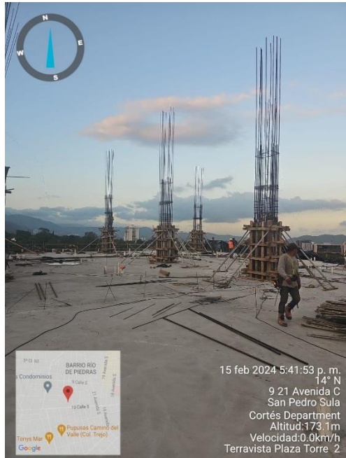
Ilustración 26 Supervisión de Acero de Columnas
