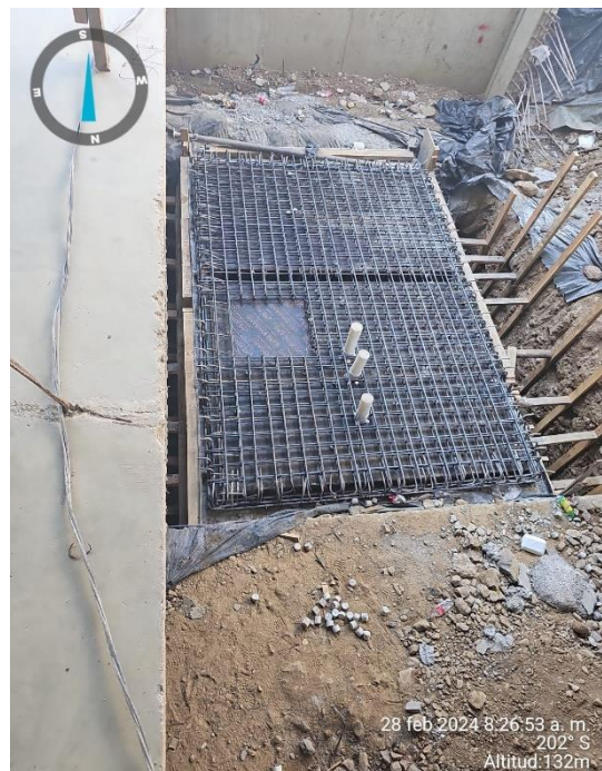
Ilustración 33 Armado de cubierta de cisterna
