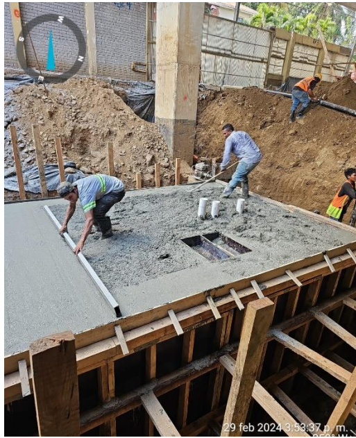
Ilustración 34 Fundición de cisterna
