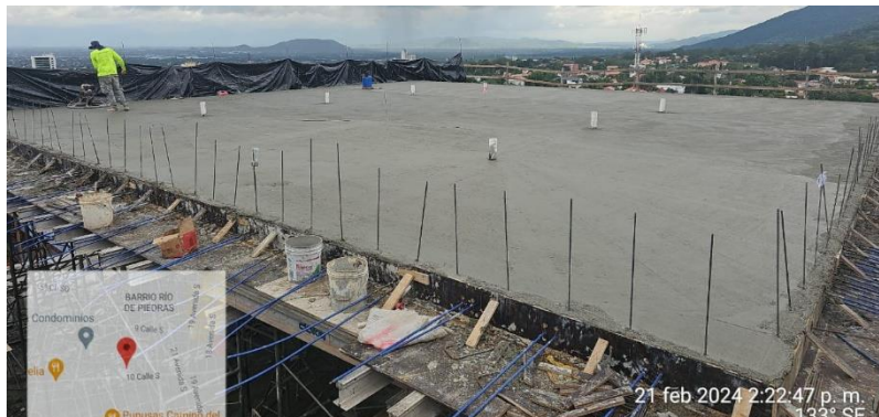
Ilustración 32 fundición de losa 8B
