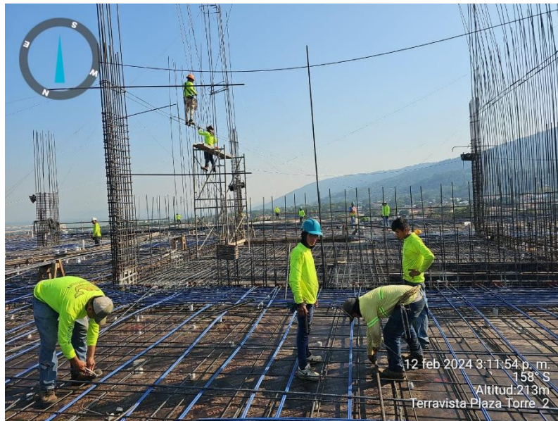
Ilustración 23 Supervisión de Cables
