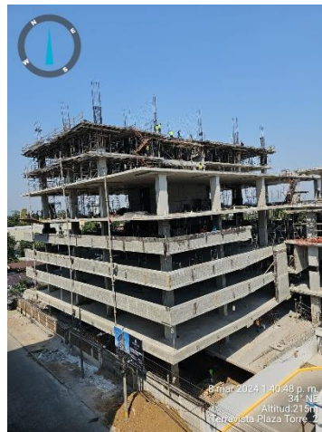
Ilustración 37 Construcción de pared de estacionamientos
