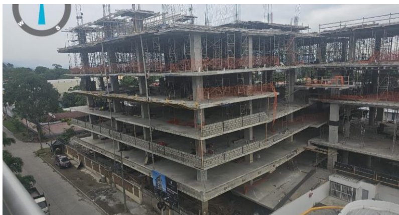
Ilustración 29 Construcción de paredes
