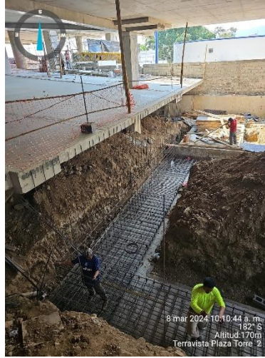
Ilustración 38 Armado de zapata
