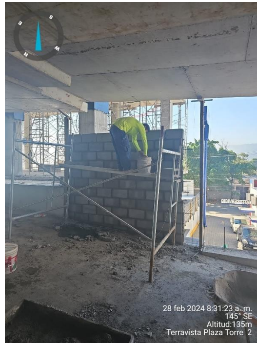
Ilustración 36 Construcción de pared de 3.4 m longitud
