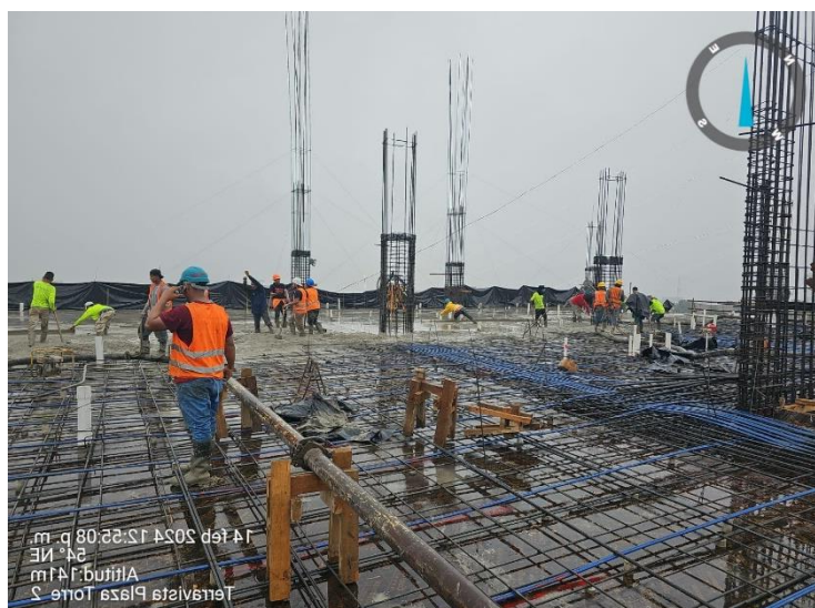
Ilustración 27 Fundición de Losas
