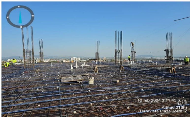
Ilustración 22 Revisión de acero de losa
