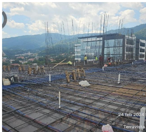
Ilustración 31 Supervisión de armado de losa nivel 9
