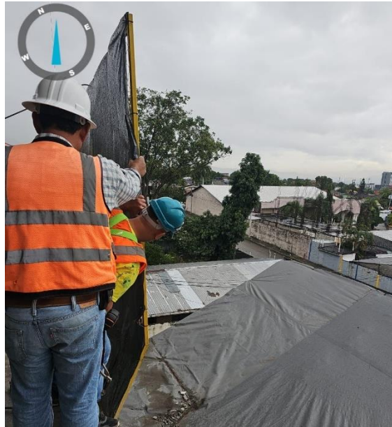
Ilustración 30 Colocación de Protección
