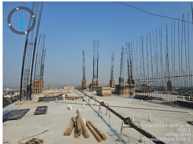
Ilustración 52 Levante de columnas
