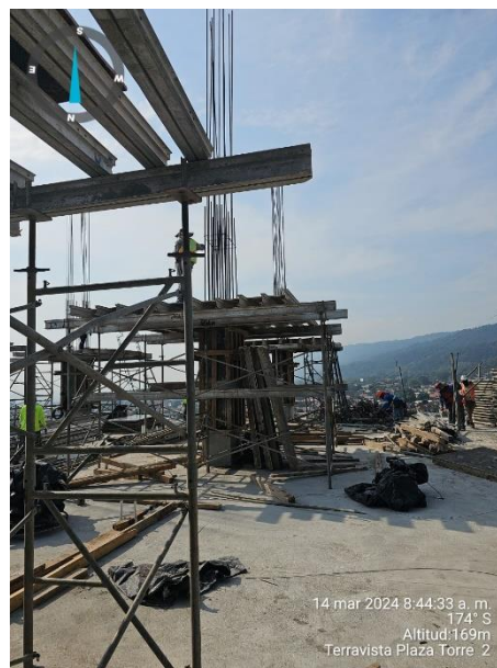
Ilustración 46 Levante de columnas
