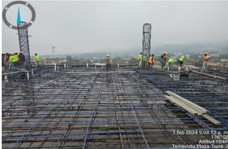
Ilustración 14 Fundición del Nivel 7B
