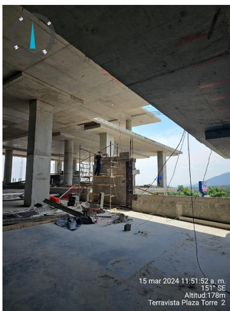
Ilustración 40 Construcción de pared de doble altura
