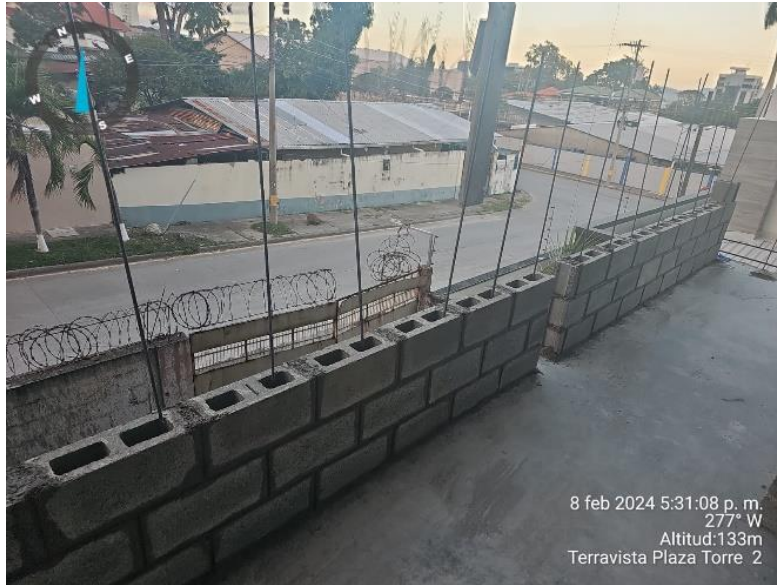
Ilustración 17 Muro de bloque perimetral
