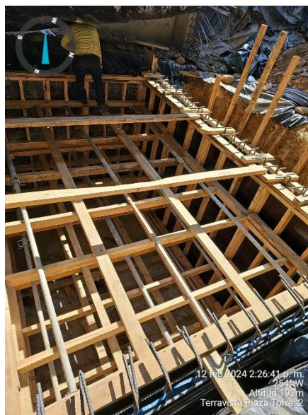
Ilustración 21 Encofrado y Armado Cisterna
