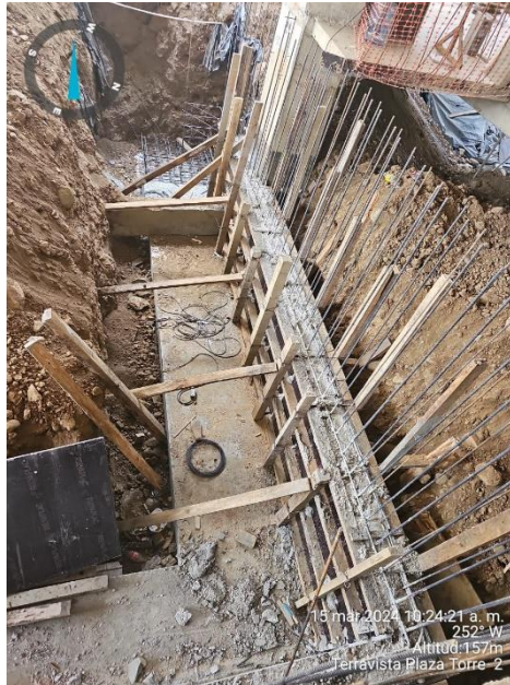
Ilustración 42 Fundición de primer levante de muro de contención
