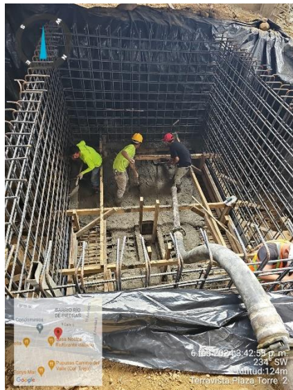
Ilustración 19 Fundición de losa de cisterna
