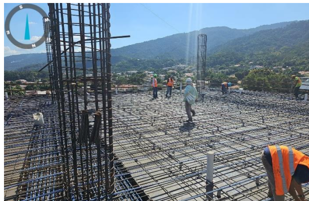
Ilustración 10 colocación de pasantes de tubería nivel 7 B
