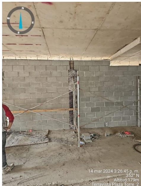
Ilustración 44 Construcción de pared nivel 2
