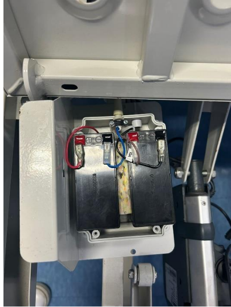
Ilustración 114 - Reemplazo de baterías en cama hospitalaria
