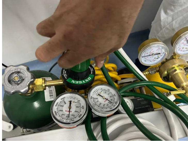
Ilustración 64 - Instalación de manómetro
