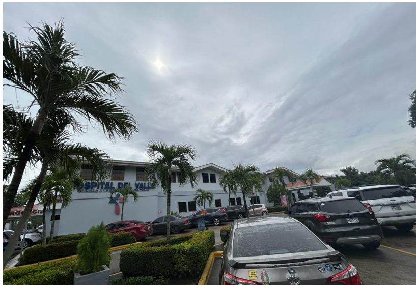
Ilustración 2 - Instalación Primaria del Hospital
