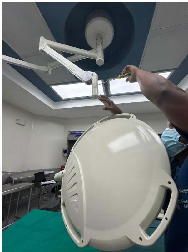
Ilustración 111 - Mantenimiento correctivo lampara quirúrgica
