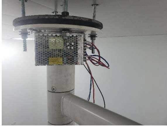
Ilustración 13. Instalación de lampara cialítica
