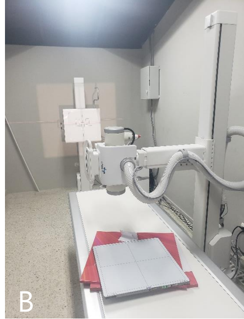
Ilustración 23. (A) Conexiones del tubo y generador (B) Alineación con bucky de pared
