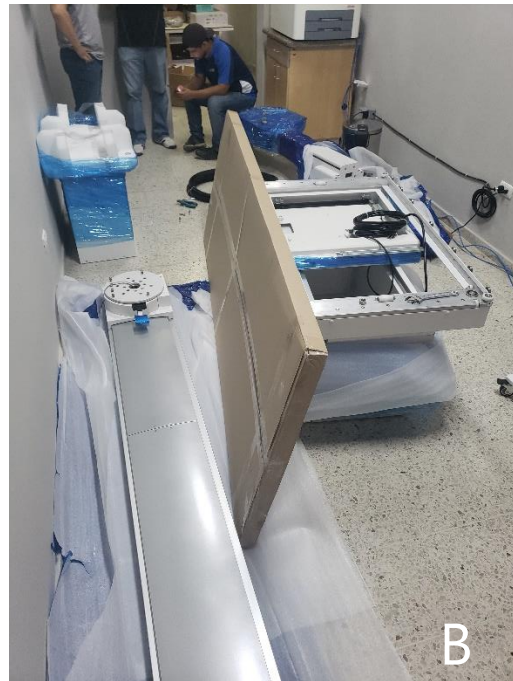
Ilustración 22. (A) Tubo de rayos X, (B) Riel y mesa de rayos X
