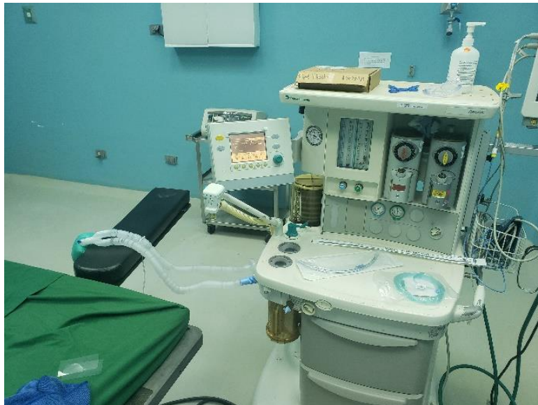
Ilustración 19. Mantenimiento preventivo a máquina de anestesia
