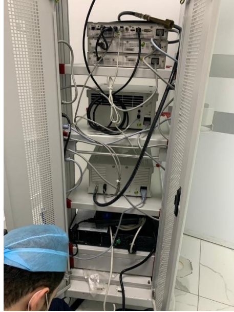
Ilustración 46 – Instalación de UPS para torre de laparoscopia
