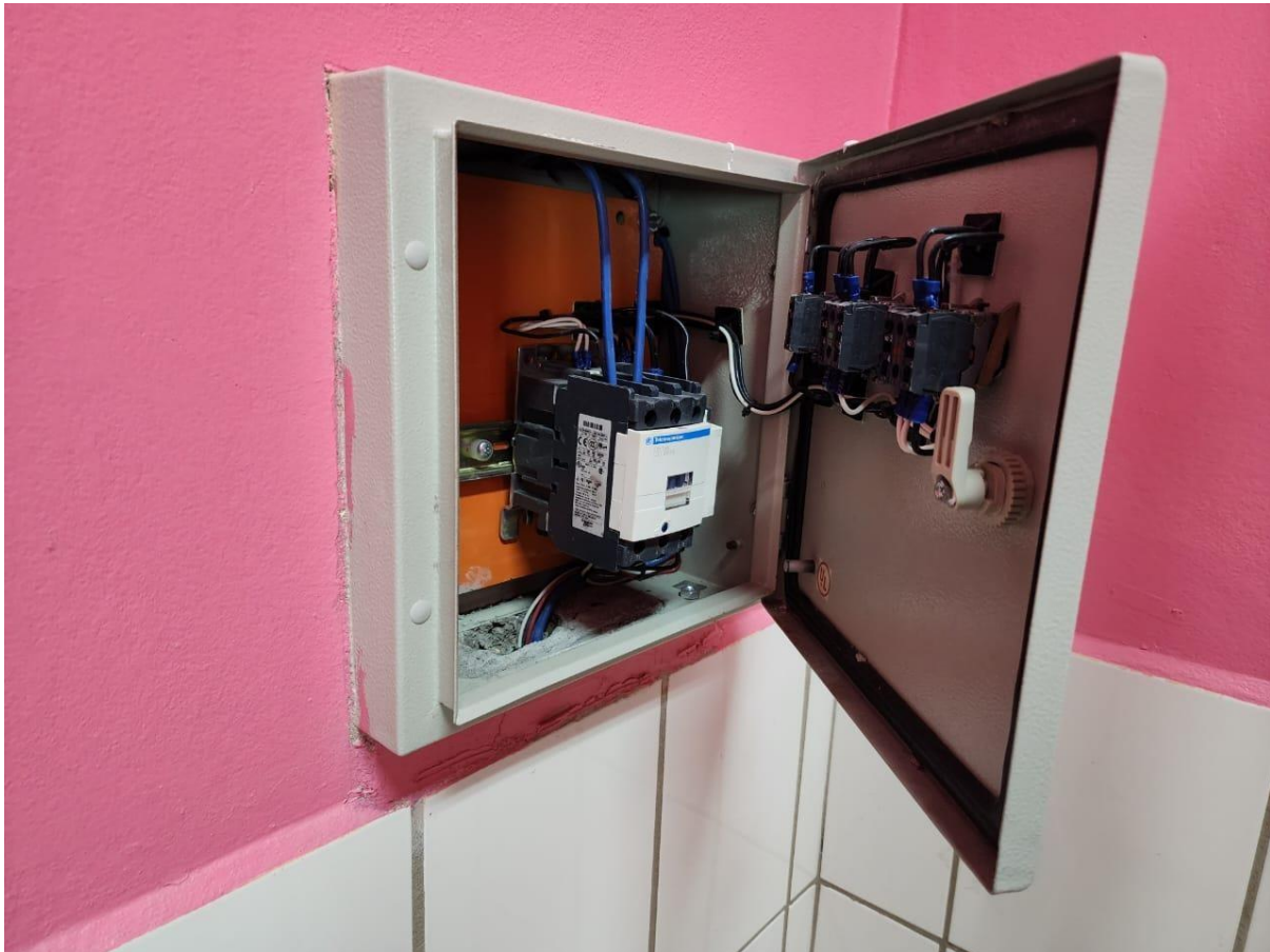
Ilustración 9- Inspección visual del tablero para la instalación de equipos de mamografías SIEMENS.
