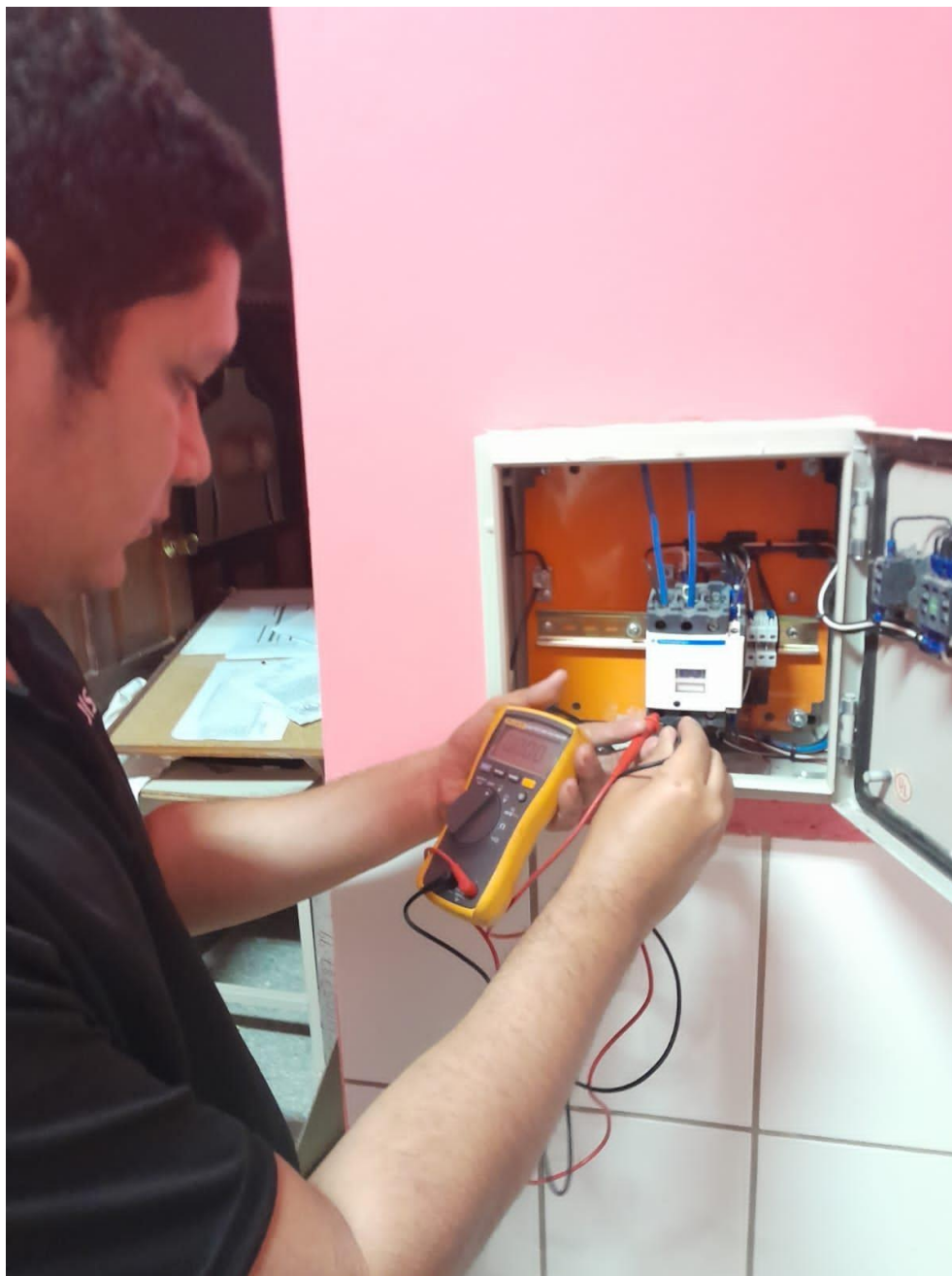
Ilustración 33- Verificación de alimentación de la caja del contactor.
