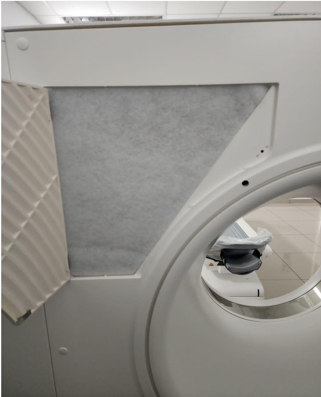
Ilustración 14- Colocación del primer filtro de aire nuevos del Tomógrafo SOMATOM go
