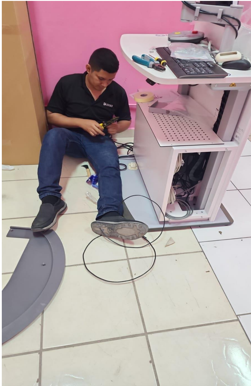
Ilustración 35- Instalación de la estación y cables de comunicación.
