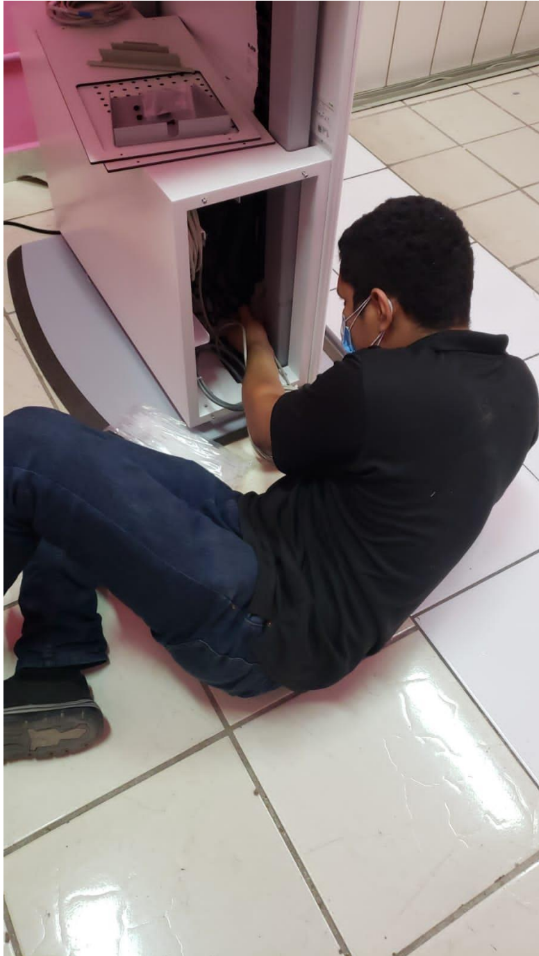
Ilustración 36- Instalación 2, de la estación y cables de comunicación.
