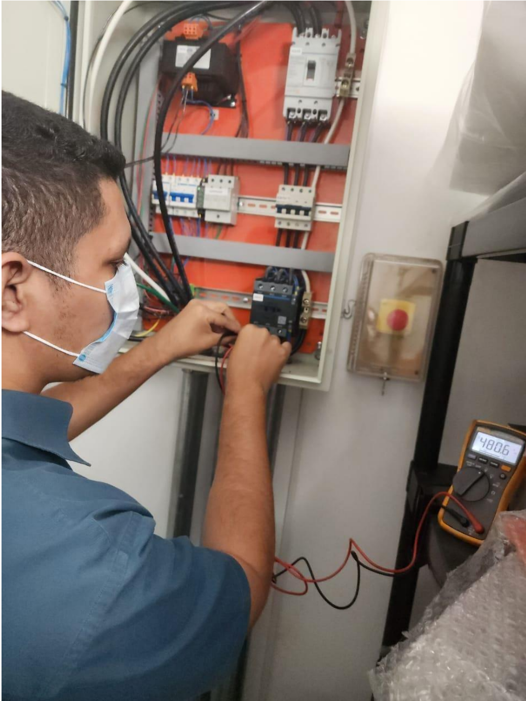
Ilustración 21- Verificación de la alimentación eléctrica(L1-L2-L3) y (PE-L1, PE-L2, PE-L3)
