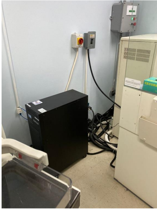
Anexo 24. Revisión de ups en mamógrafo digital.
