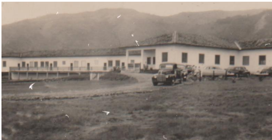
Ilustración 3. Edificación inicial del Hospital Bendaña hace 76 años.
