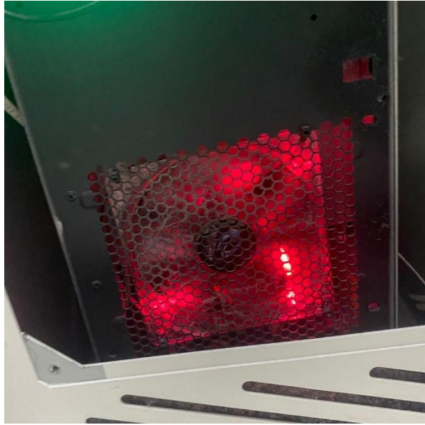
Anexo 34. Mantenimiento de la ventiladora del computador del mamógrafo digital.
