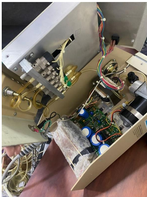
Anexo 29. Revisión de torniquete de sala de operaciones.
