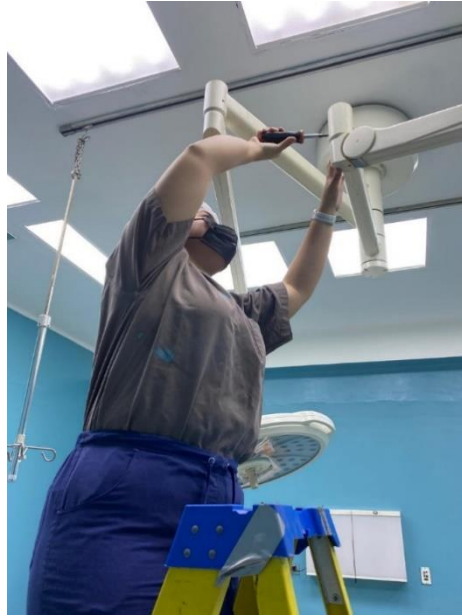
Anexo 1. Mantenimiento de las lámparas celiáticas en sala de operaciones.
