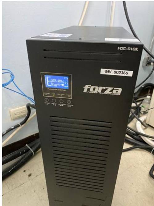
Anexo 25. Revisión de ups en mamógrafo digital.
