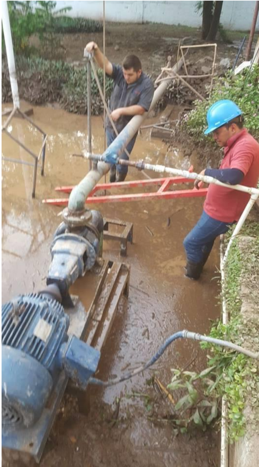
Ilustración 26. Instalación de bomba de fosa séptica
