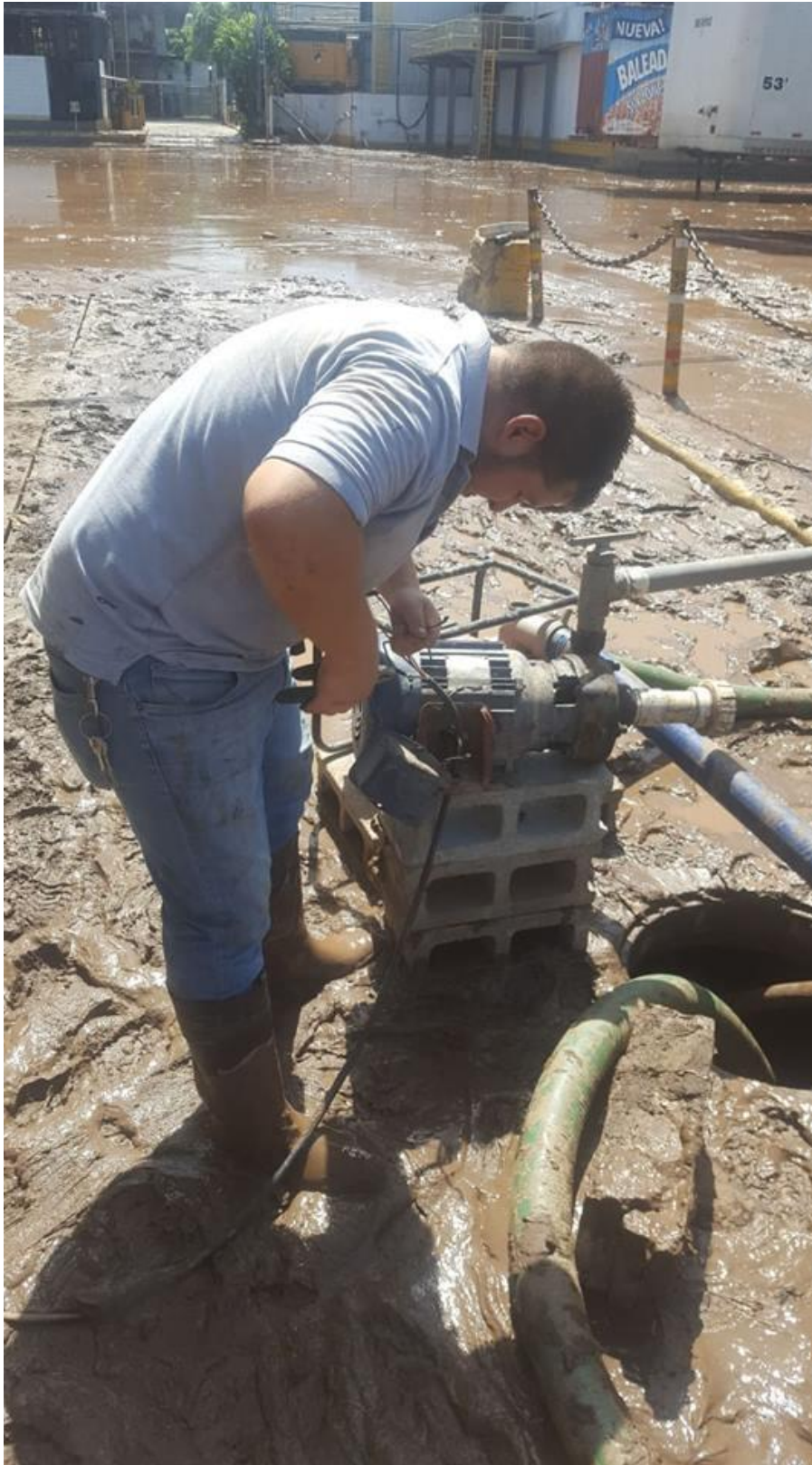
Ilustración 22. Instalación de bomba de agua para limpiar área contaminada por lluvias
