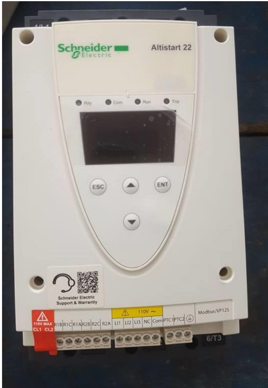
Ilustración 28. Arrancador suave para pozo de agua #2
