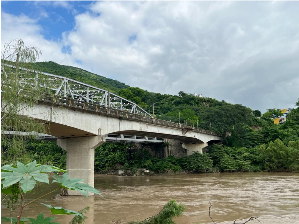
Ilustración 34 - Vista desde el margen derecho del puente Chamelecón
