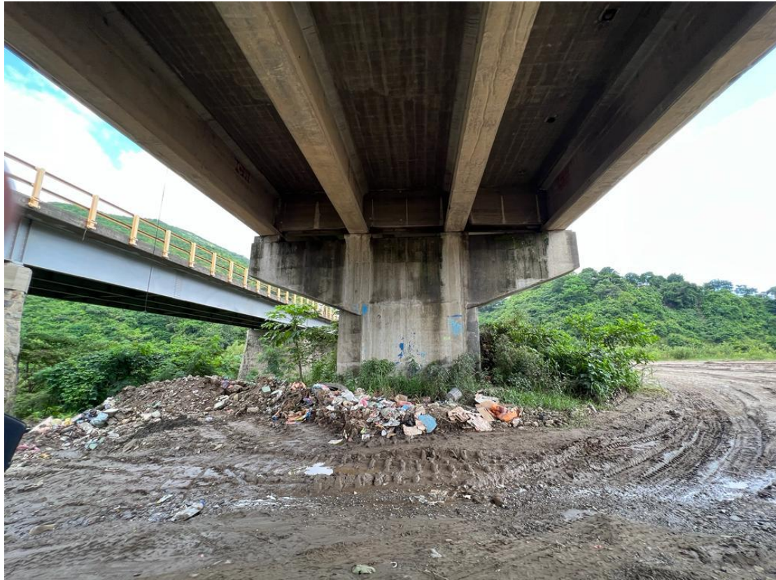
Ilustración 43 - Vista desde la parte inferior del puente
