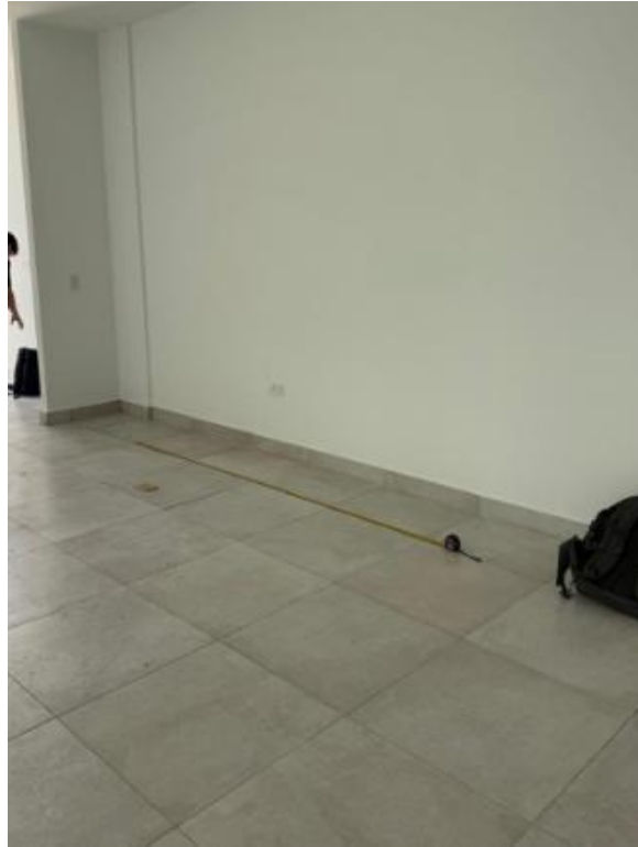
Ilustración 79 Medición y ubicación para instalación de equipo
