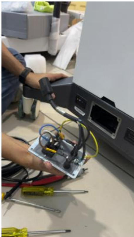
Ilustración 202 Instalación de CPET
