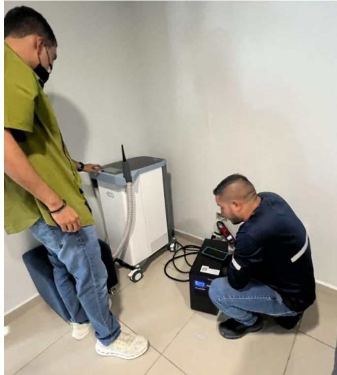
Ilustración 39 Inspección de Instalaciones eléctricas
