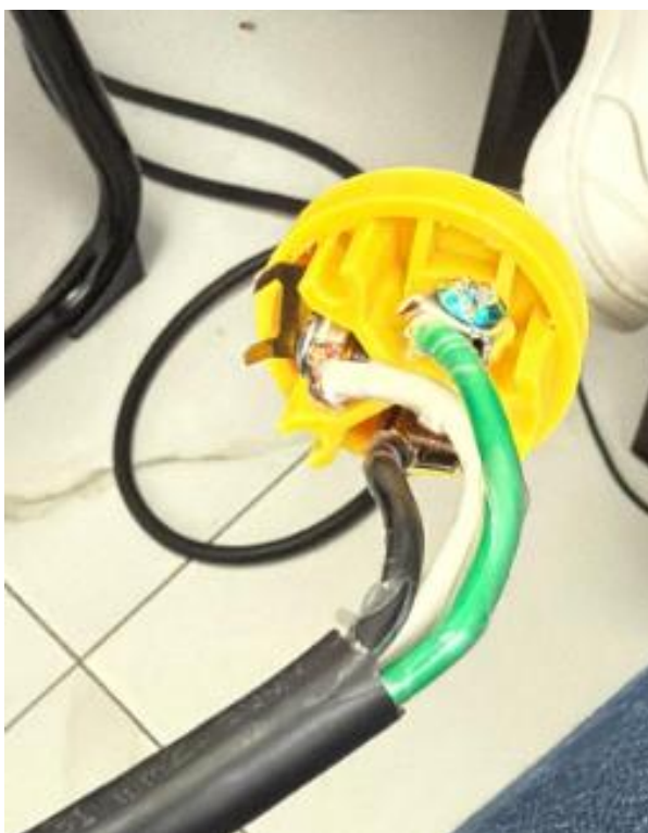
Ilustración 138 Realización de conexión para adaptador de UPS
