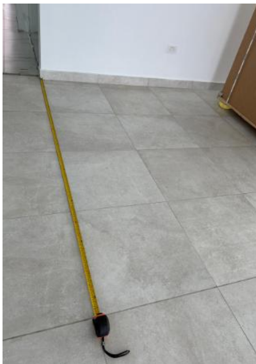
Ilustración 137 Mediciones para instalación de equipos y de alfombra en nueva instalación de rehabilitación cardiaca
