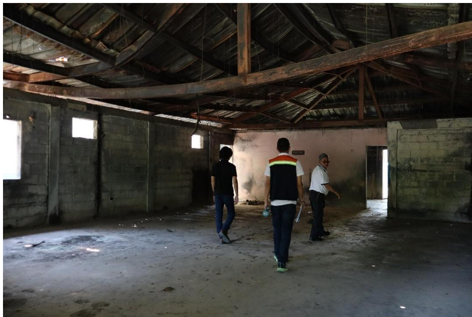
Condiciones interiores del Inmueble
