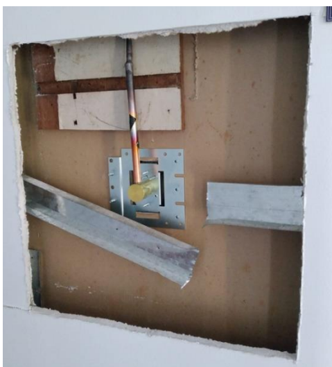
Ilustración 53. Reemplazo y soldadura de tubería de cobre
