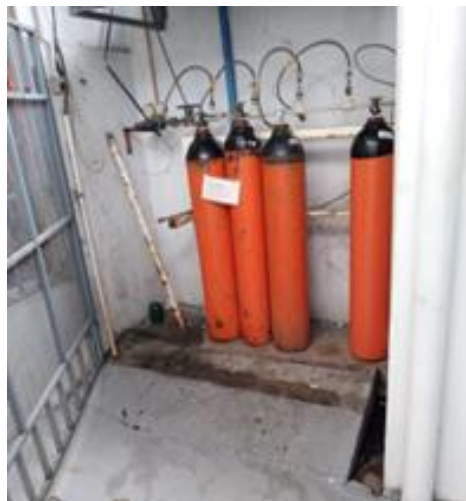
Ilustración 44. Cilindros de respaldo de aire comprimido
