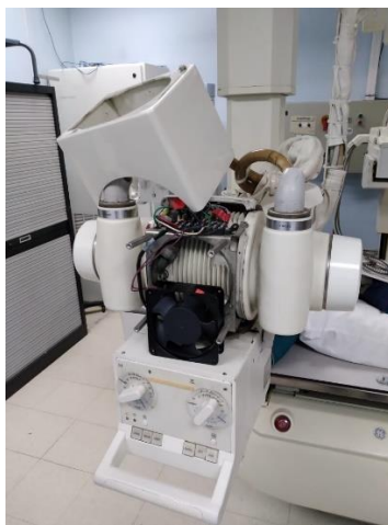
Ilustración 38. Cambio de ventiladora en Rx estacionario
