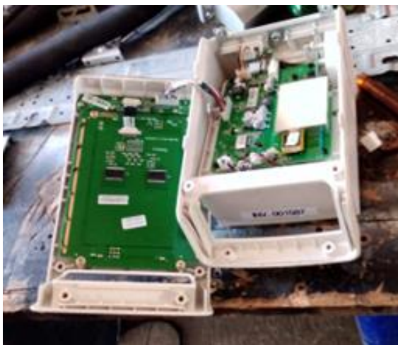
Ilustración 69. Limpieza de las tarjetas internas del MSV
