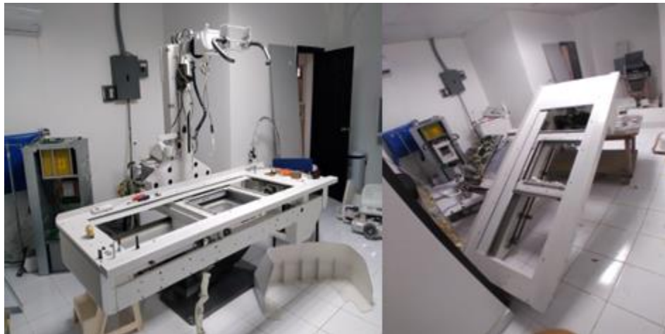
Ilustración 77. Desmontaje del Fluoroscopio estacionario
