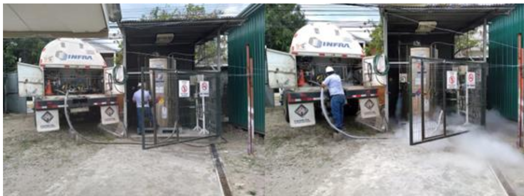
Ilustración 42. Llenado del tanque criogénico
