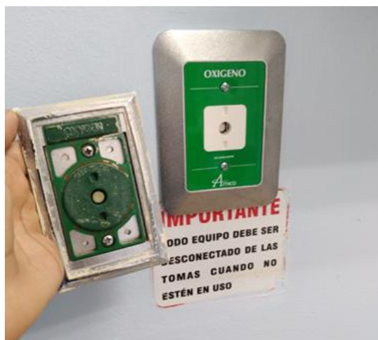
Ilustración 52. Cambio de tomas de oxígeno en Suites
