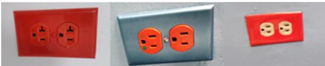
Ilustración 19. Tomacorrientes aterrizados para equipo médico
