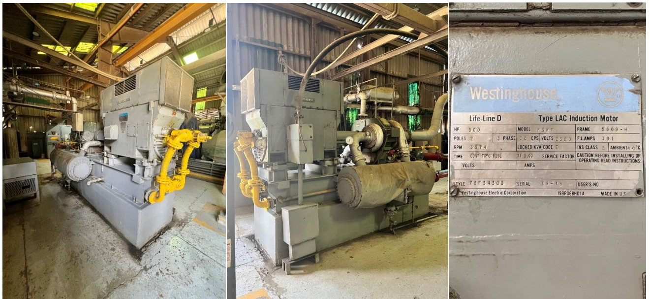
Figura 46. Datos técnicos de compresores Joy
