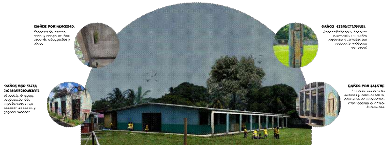
Figura 120. Análisis de Daños Existentes CEB Miguel Paz Barahona
