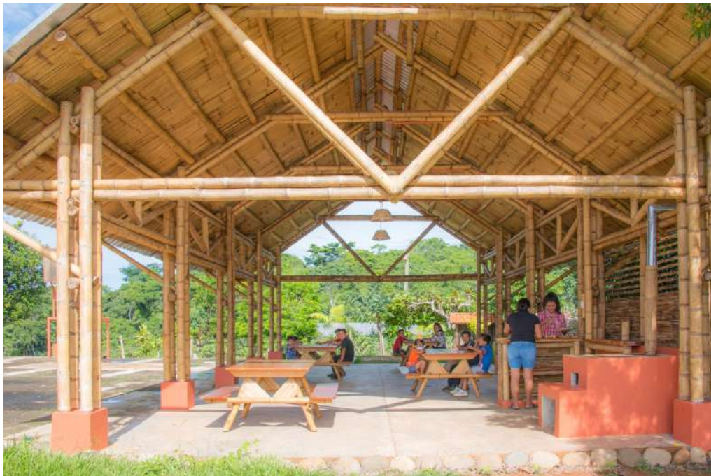
Figura 16. Área Exterior con Techo de Bambú utilizado como Comedor
