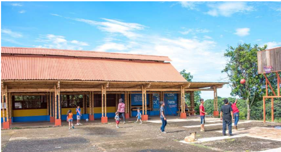
Figura 15. Área Exterior con Techo de Bambú
