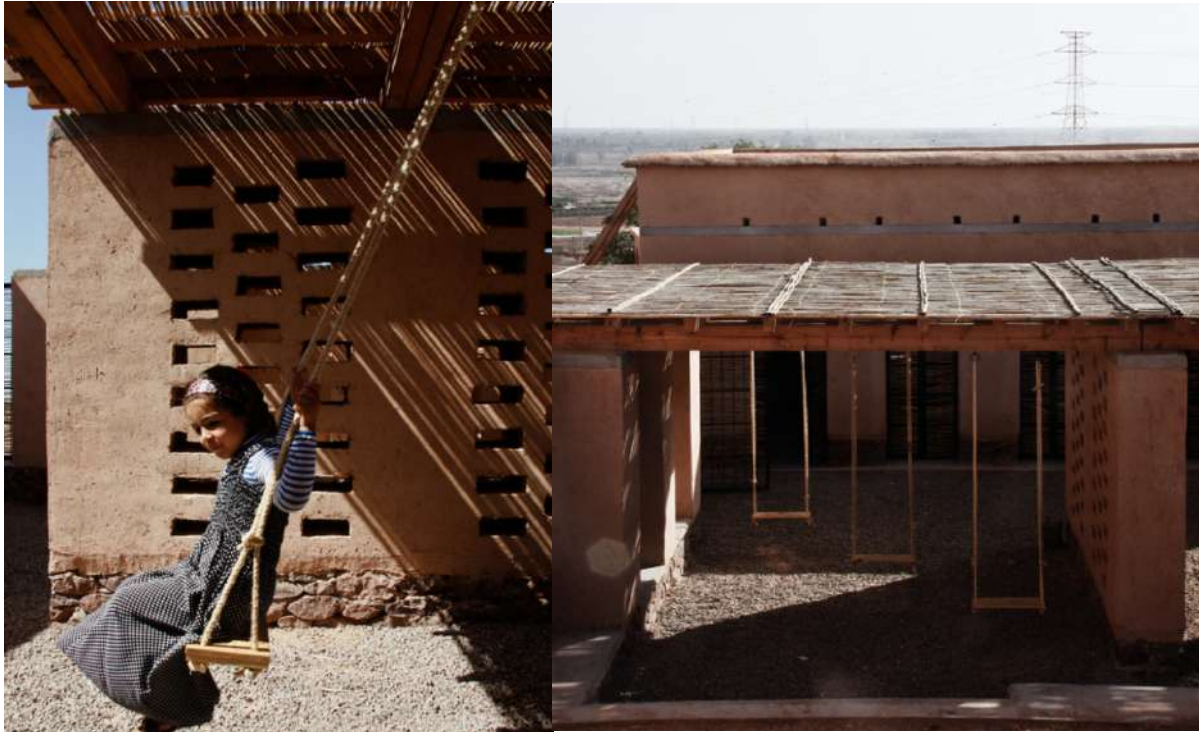
Figura 74. Detalle de Fachada
