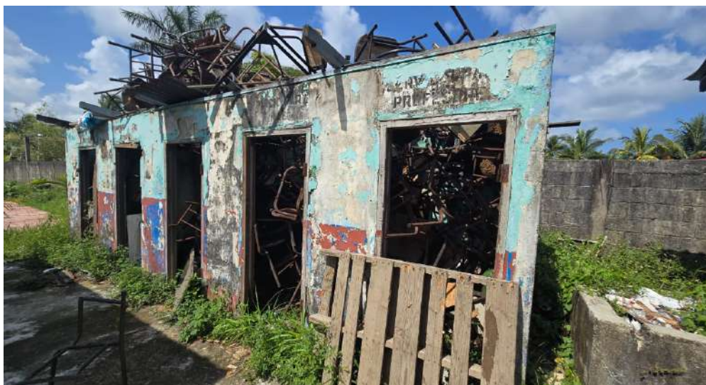
Figura 55. Antigo módulo escolar en desuso convertido en depósito de mobiliario deteriorado.
