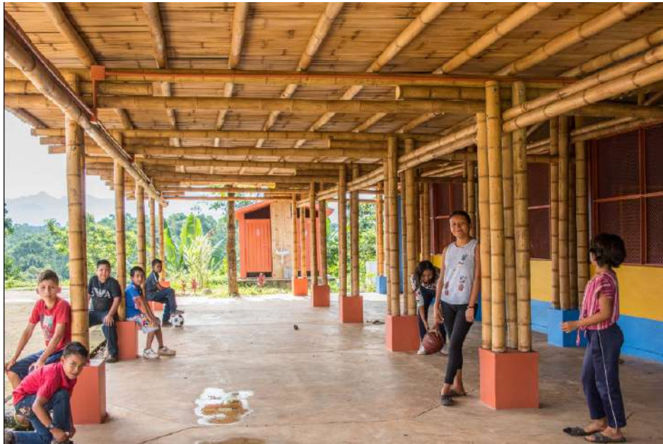
Figura 17. Detalle de la Estructura de Bambú en la Cubierta
