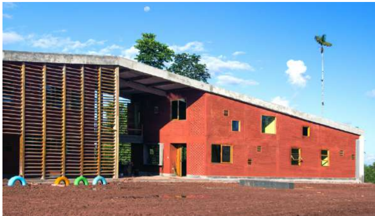
Figura 19. Vista exterior del edificio principal con fachada de ladrillo y persianas de madera
