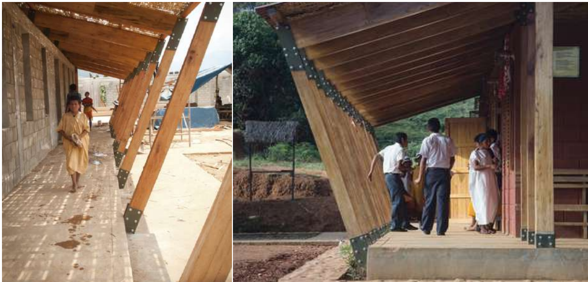
Figura 70. Cubierta inclinada con estructura de madera local y caña, ejemplo de arquitectura adaptada al clima y al contexto cultural.
