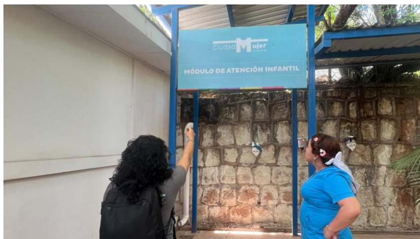
Figura 50 Fotografía de la Tubería Aplicada dentro del Módulo MAI
