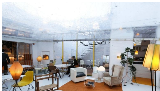
Figura 22 Cubierta Translúcida para Iluminación Natural y Aislamiento Térmico
