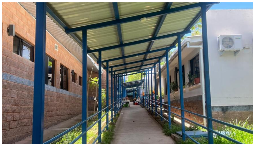
Figura 44 Fotografía de Pasillo Exteriores del CCM Tegucigalpa
