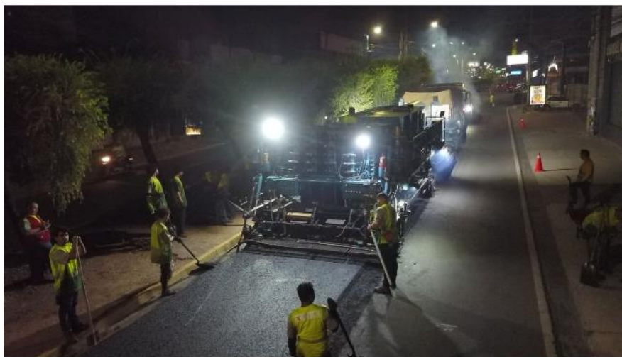
Figura 6: Imagen del proyecto utilizando la maquina recicladora asfáltica
