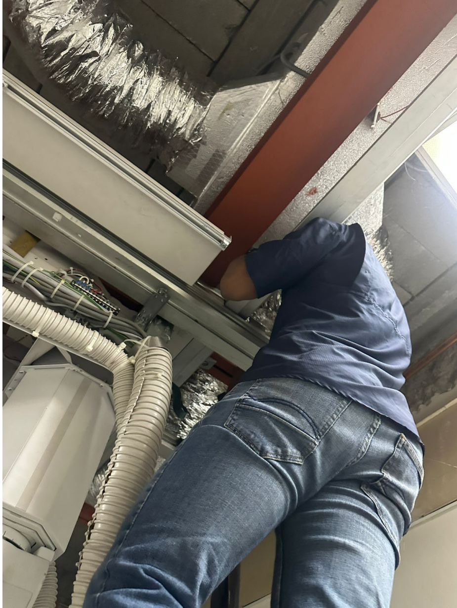
Ilustración 7: Instalación de rieles
