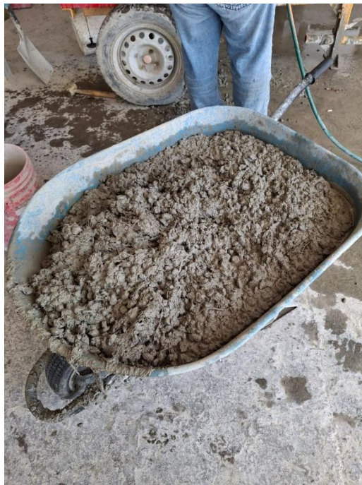
Ilustración 64. Mezcla de concreto con adición de fibra.
