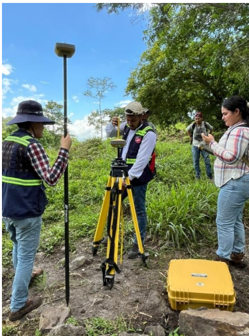
Anexo 1 - Inicio del levantamiento topográfico de la línea de conducción
