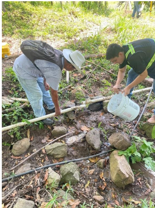
Anexo 6 - Aforo de la obra de toma para medir el caudal
