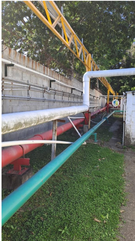
Ilustración 19-Tuberías Muro Perimetral
