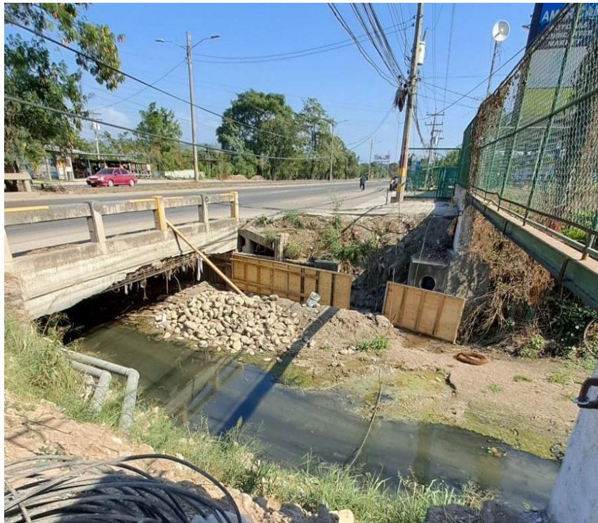
Ilustración 21-Encofrado Aletas
