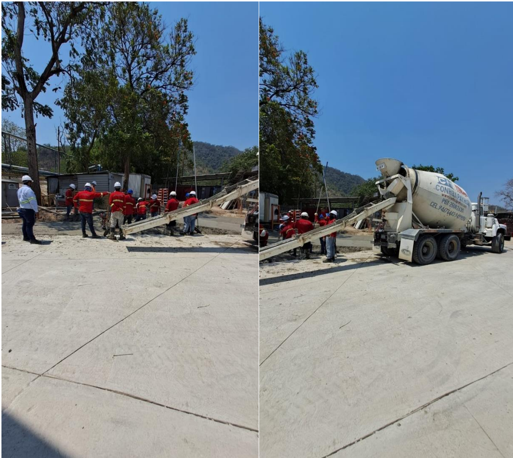
Ilustración 27-Fundición de Losa
