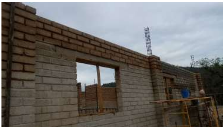
Ilustración 83. Cargadores sobre ventanas
