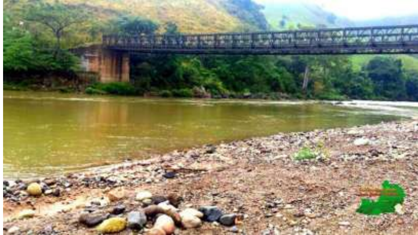
Ilustración 16. Puente Bailey sobre río Ulúa
