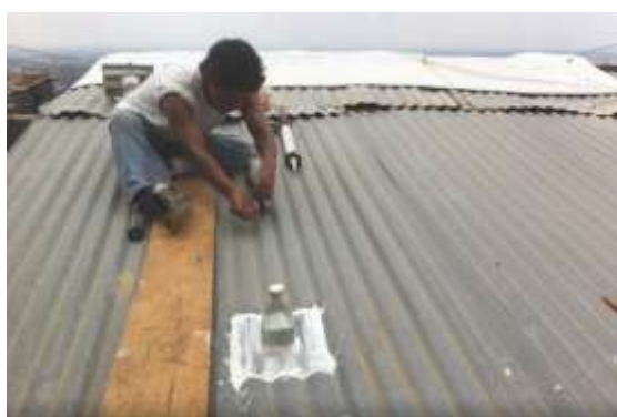
Ilustración 72. Proceso constructivo de iluminación a base de PET
