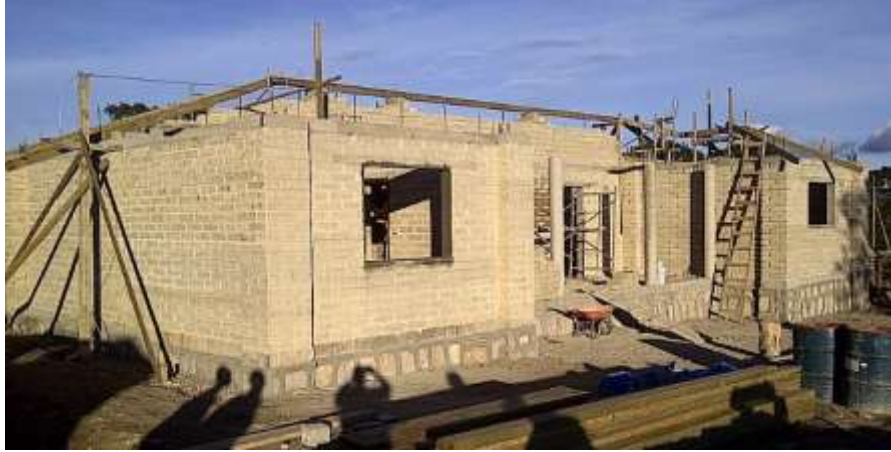
Ilustración 114. Proceso constructivo con sistema de adobe
