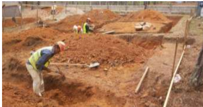
Ilustración 80. Excavaciones para la cimentación
