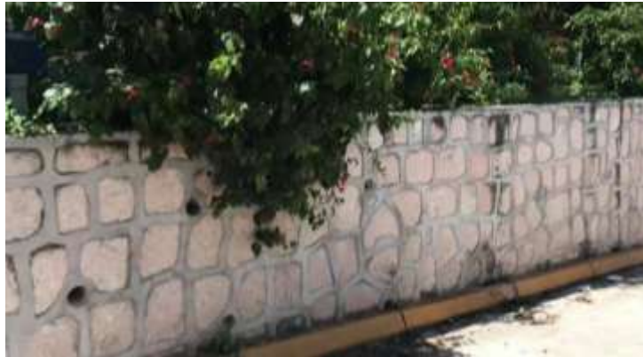
Ilustración 152. Muros construidos con piedra local
