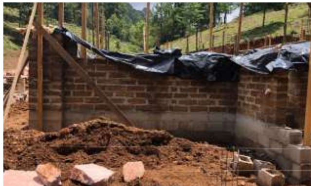
Ilustración 76: Ejemplo de sobrecimiento en proyecto de Valle de Ángeles
