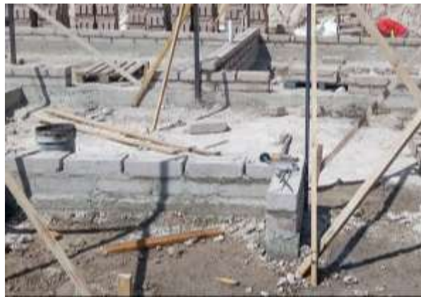
Ilustración 78. Proceso constructivo en proyecto de Gracias, Lempira
