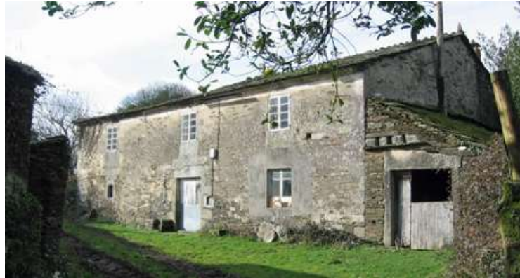
Ilustración 28. Fachada posterior de la vivienda tradicional
