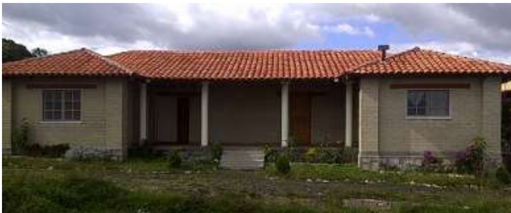
Ilustración 113. Proyecto Santa Ana, vivienda con ADB-Concreto
