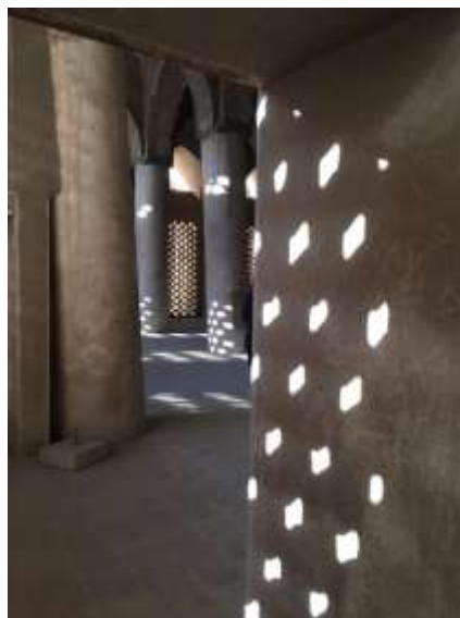
Ilustración 66. Muro translúcido a través de bloques
