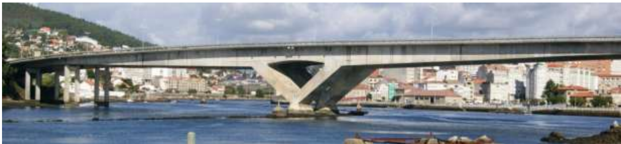
Ilustración 94. Puente de viga sobre río de Pontevedra, España
