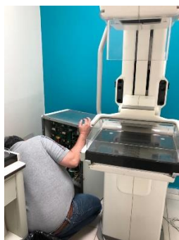
Ilustración 29 Supervisión de reparación de mamógrafo
