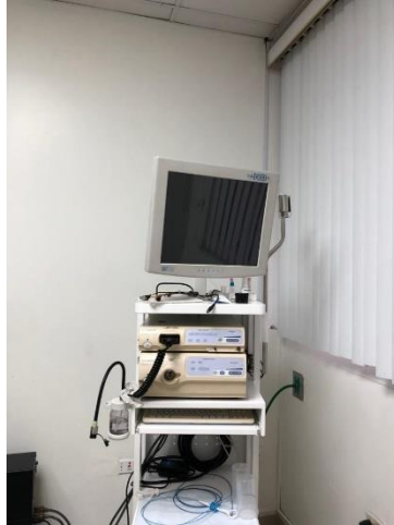
Ilustración 12 Instalación e inspección de monitor de torre de endoscopia
