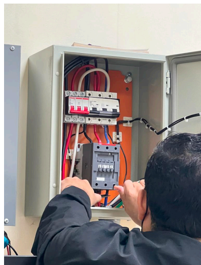
Ilustración 46: Instalación de botón de paro de Rayos X Estacionario
