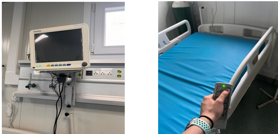
Ilustración 27: Instalación de Equipo en Hospital Móvil
