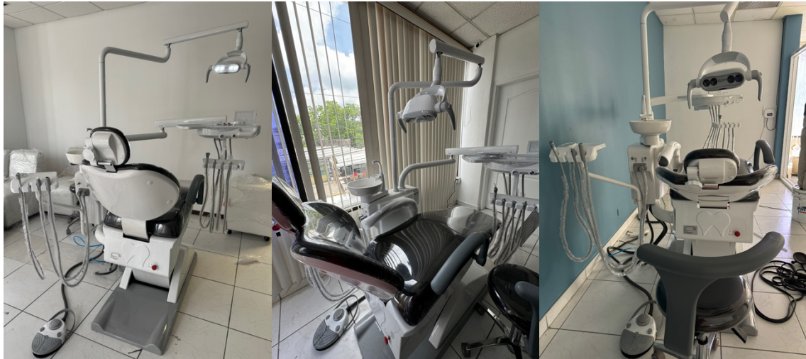
Ilustración 23. Instalación de Unidades Dentales - S5
