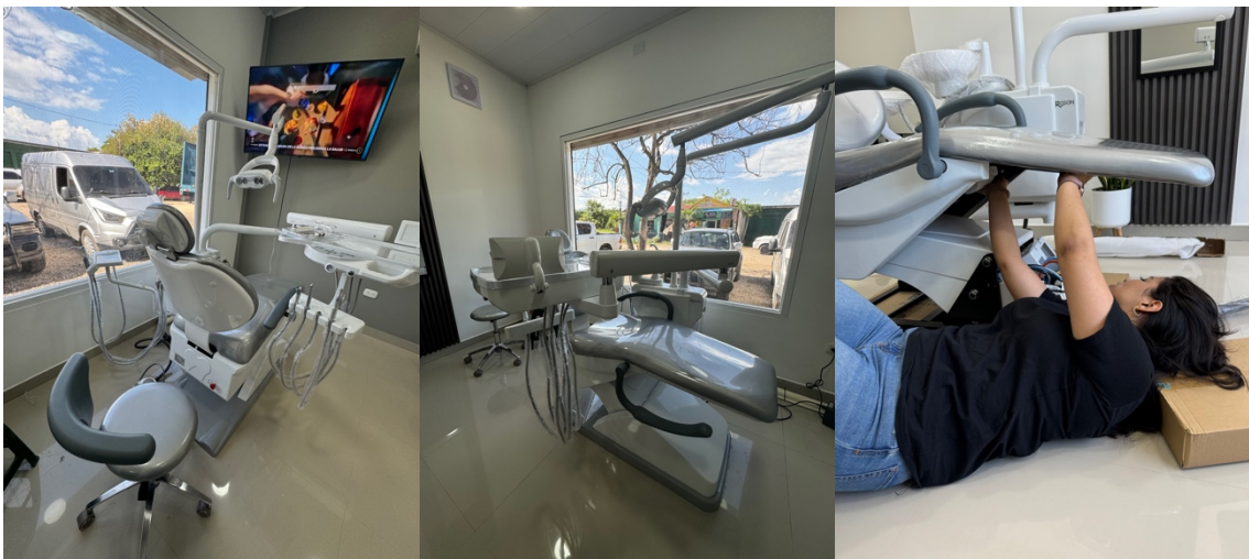
Ilustración 7. Instalación de Unidad Dental S2
