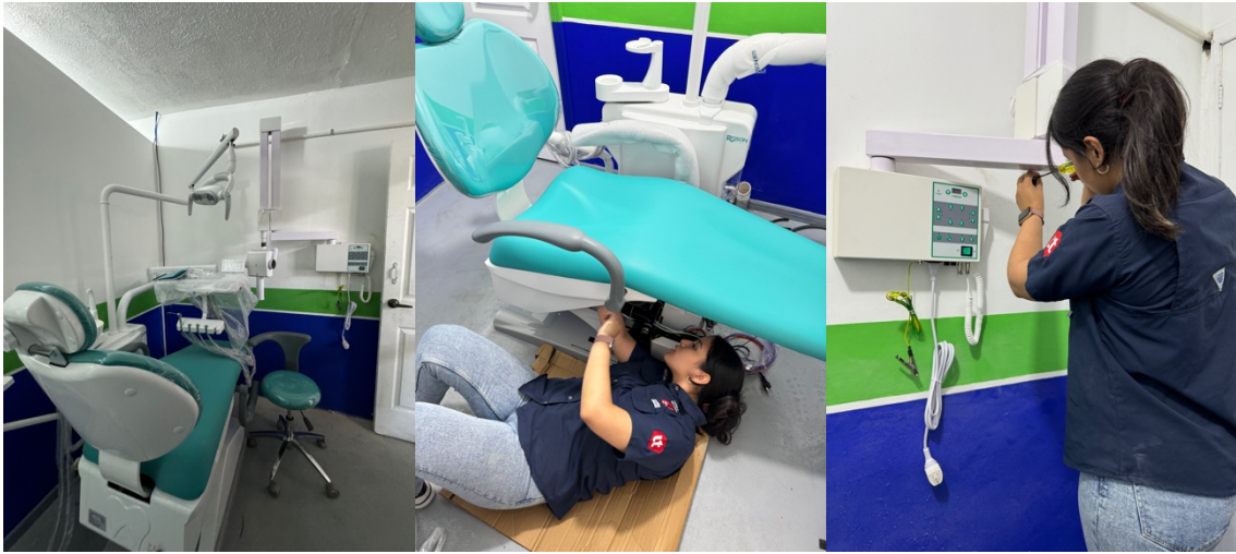
Ilustración 5. Instalación de Unidad Dental S2
