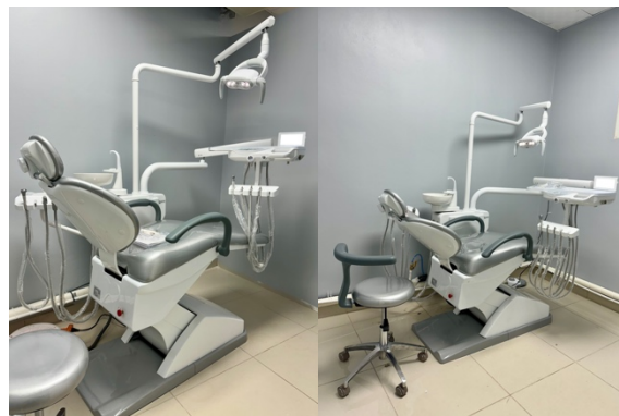
Ilustración 18. Instalación de Unidades Dentales - S4
