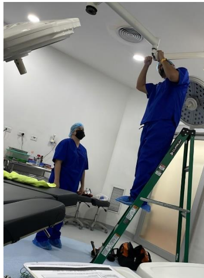
Anexo 21. Mantenimiento correctivo con IMECSA
