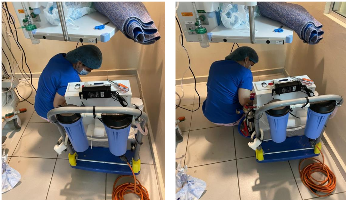
Ilustración 21: Instalación de equipo intrahospitalario
