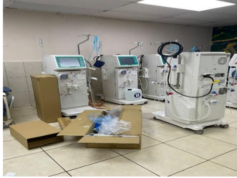
Ilustración 13: Instalación de equipo de hemodiálisis en Diálisis de Honduras
