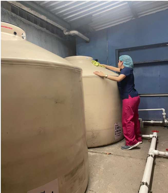
Ilustración 18: Limpieza de tanques de agua cruda
