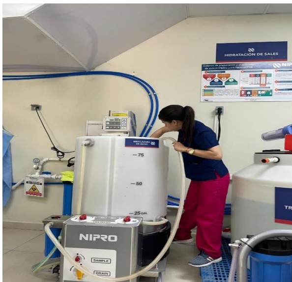
Ilustración 11: Limpieza de la mezcladora de ácido
